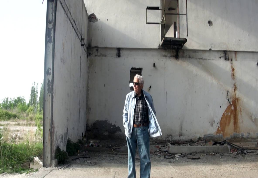
Resim-107: Kereste Fabrikası’nın metruk binası içinde Hulusi Sarısoy
