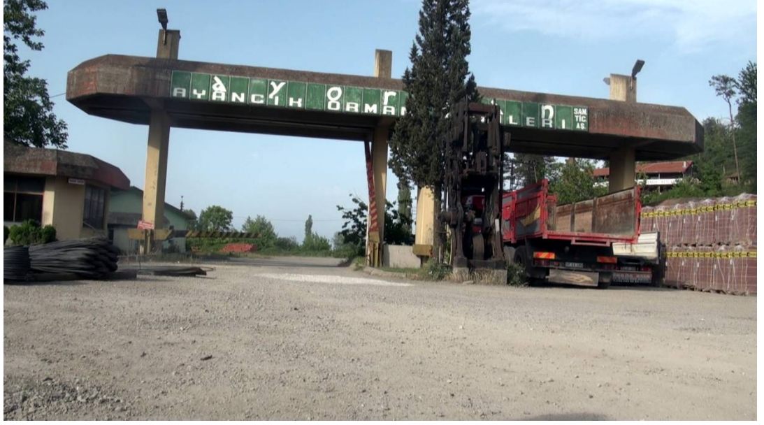
Resim-99: Ayancık'taki eski Kereste Fabrikası'nın girişi
