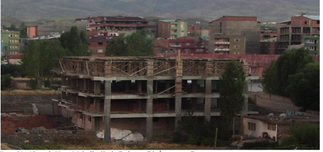
Foto 62: Ahmedi Hani Mahallesi'nde Bulunan Bir İnşaattan Görünüm
