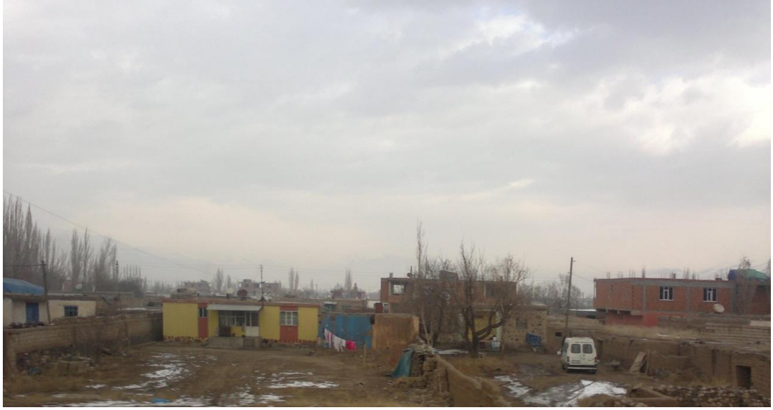
Foto 71: Tek Katlı Evlerin Yoğun Bulunduğu Yeni Mahalle'den Bir Görünüm
