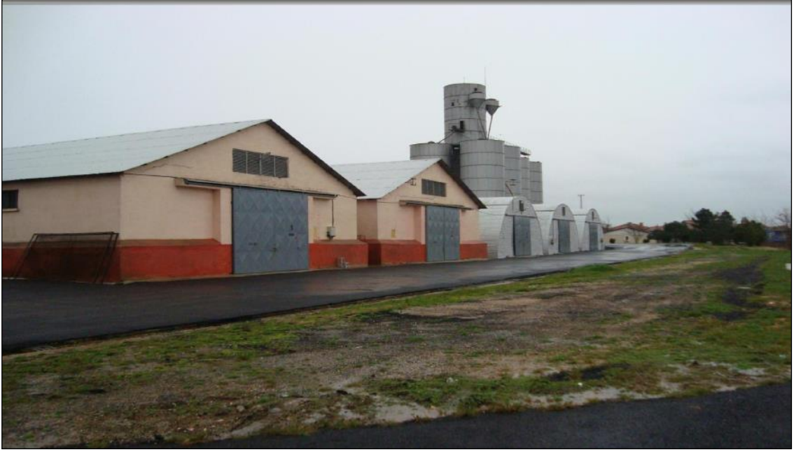
Şekil 1.3. Betonarme depo (solda), quanset çelik hangar (sağda), colombian çelik silo (arkada) genel görünüşü (Orijinal)
