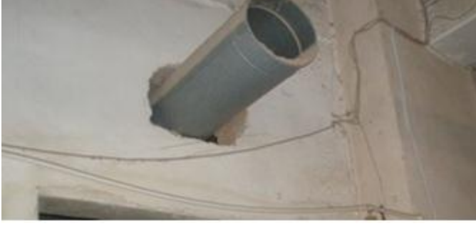
Şekil 1.3 Toz emme borularında biriken talaş
