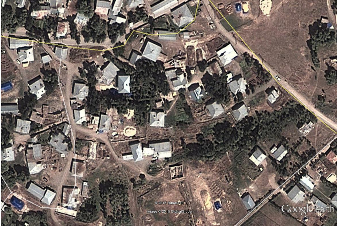
Fotoğraf 3.1. Hamur İlçe Merkezi'ndeki Plansız Yapılaşmaya Bir Örnek (Google Earth).
