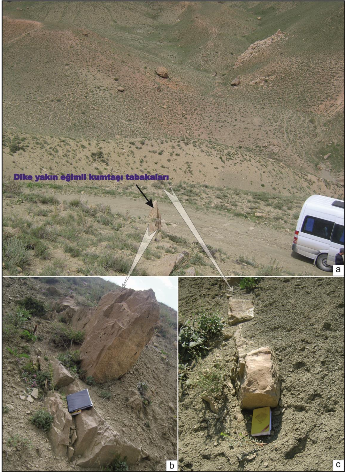
Şekil 4.34. Çalışma alanının güneyinde Van Formasyonunun güneye doğru itilmesi sonucu kumtaşı tabakalarında meydana gelen dikleşme (Haramigedik vadi mevki). (a) yaklaşık D-B uzanımlı bindirme hattı (bakış yönü KD). (b,c) dike yakın eğime sahip kumtaşları (bakış yönü batı).
