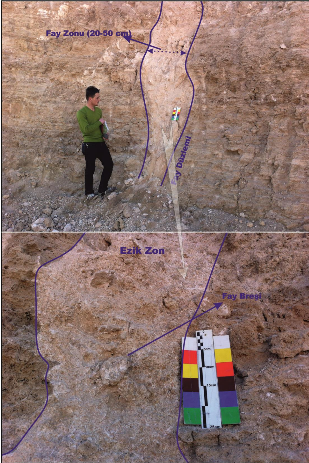
Şekil 4.40. TOKİ konutları mevkiî temel kazısında açılan yarmada gözlenen ezik zon (bakış yönü Kuzey).
