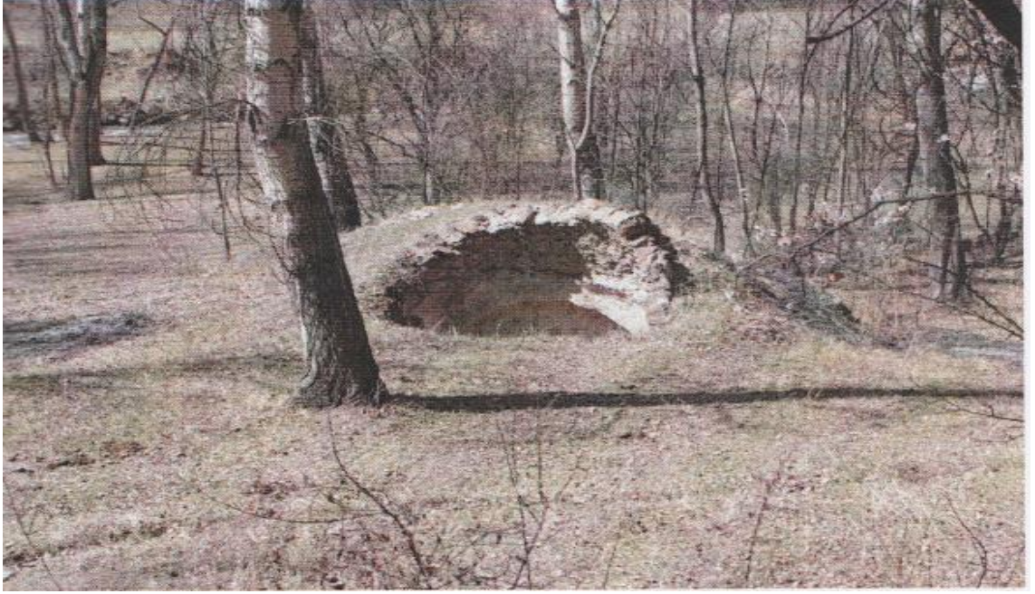
Fotoğraf 3.67. Tortumkale Köyü Hamamı Güney Cephe
