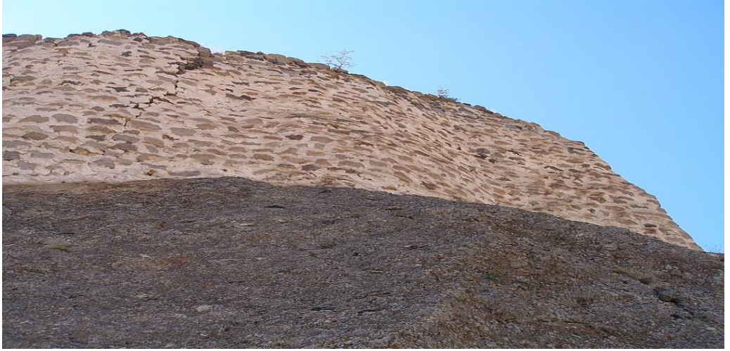
Fotoğraf 3.29. Kaledibi Kalesi Sur Duvar Örgüsü
