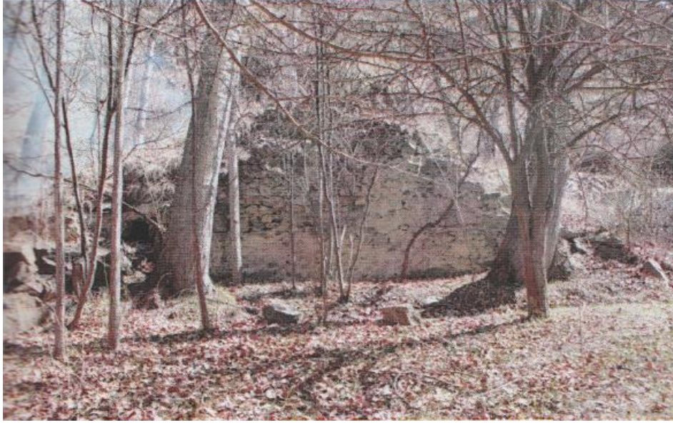
Fotoğraf 3.66. Tortumkale Köyü Hamamı Kuzey Cephe
