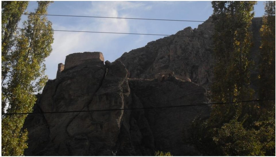
Fotoğraf 3.35. Ağcakale Kalesi (Engüzek Kalesi) Doğu Cephesi
