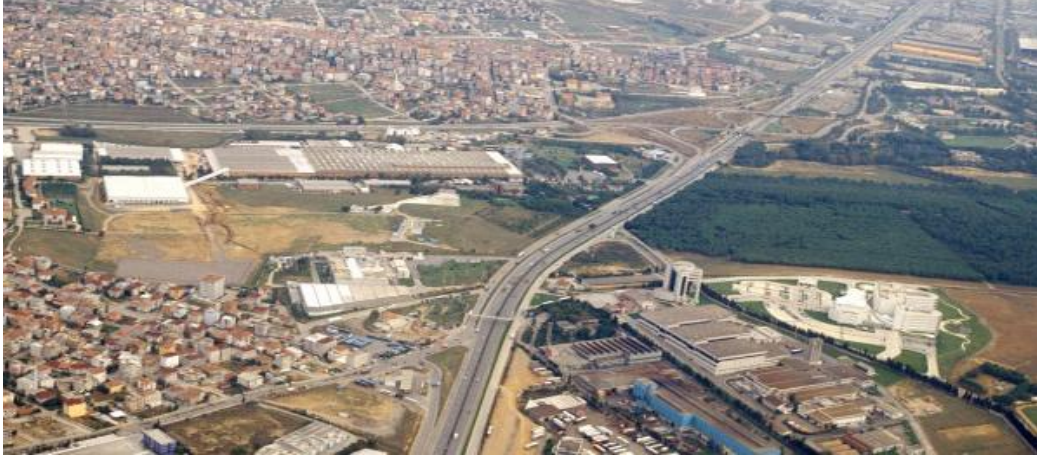
Şekil 2.6 : Çayırova Genel Görünüm (Kahraman, 2014)
