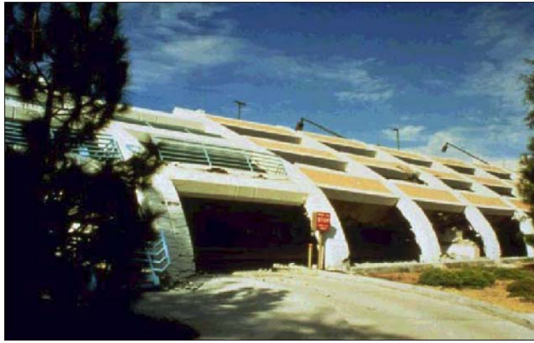
Şekil 2.8: 1994 California – Northridge Depremi’nde hasar alan bir yapı [22]
