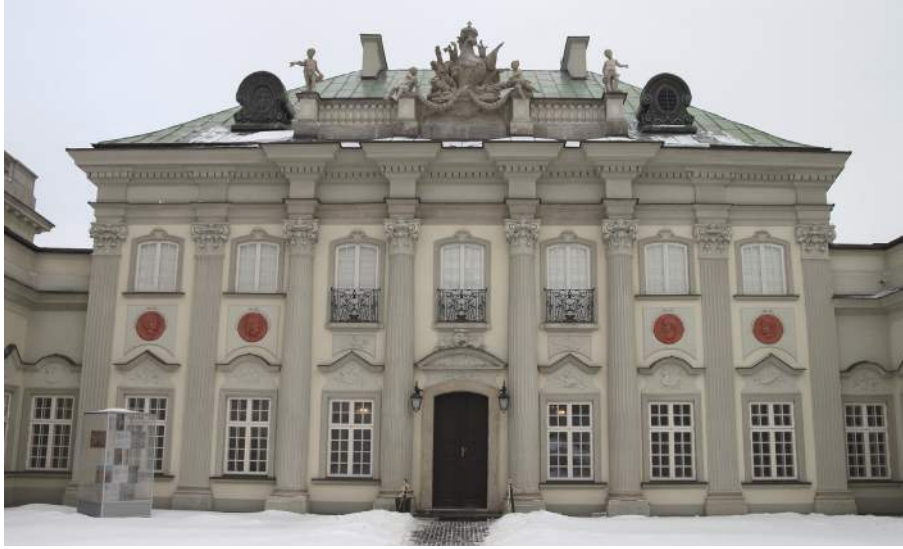
Resim 39: Bakır Çatı Sarayı 142 .
