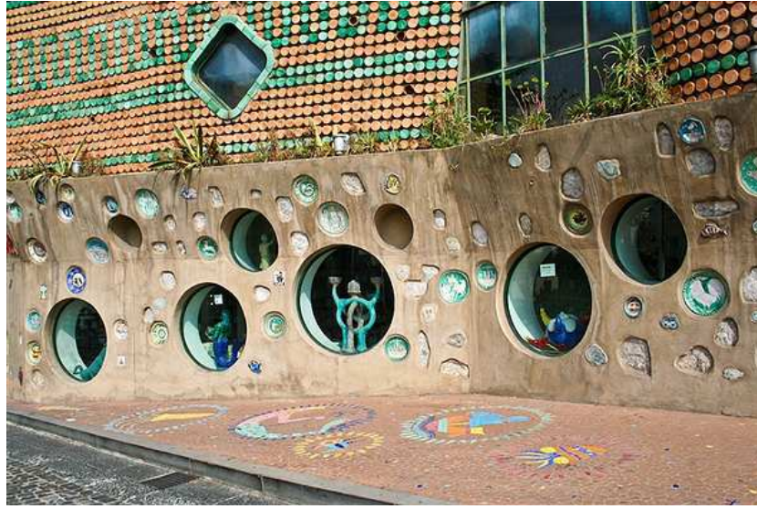
Şekil 2.43. Solimene seramik fabrikası, cephe detayı.
