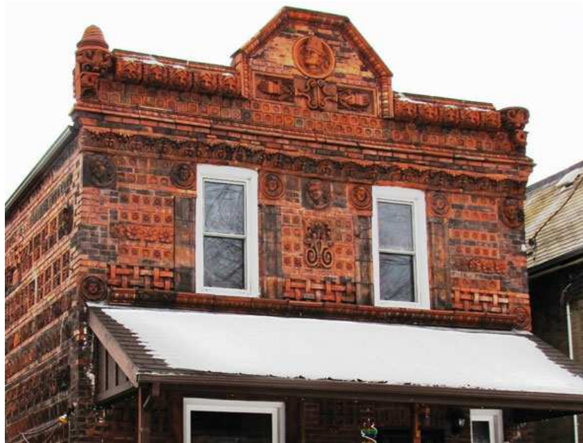
Şekil 2.38. Dekoratif terracotta kaplı cephe (New York, 1920'ler).
