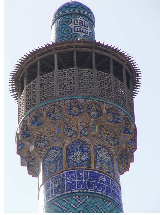
Şekil 2.21. İshafan Camii minaresi (16.yy.).
