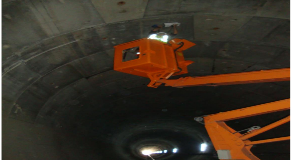
Şekil 4.8: Tünel içi Yapı Radarı (GPR) yöntemiyle veri toplama çalışmaları.
