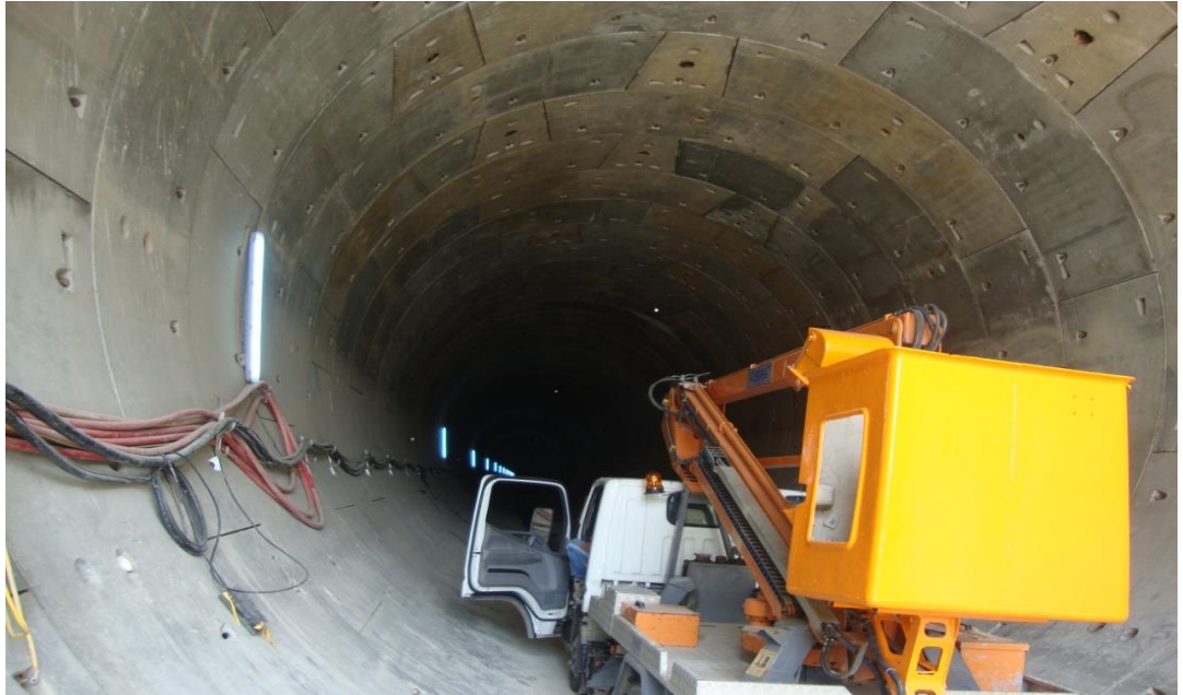
Şekil 4.7: Tünel içi Yapı Radarı(GPR) yöntemiyle veri toplama çalışmalarına hazırlık.
