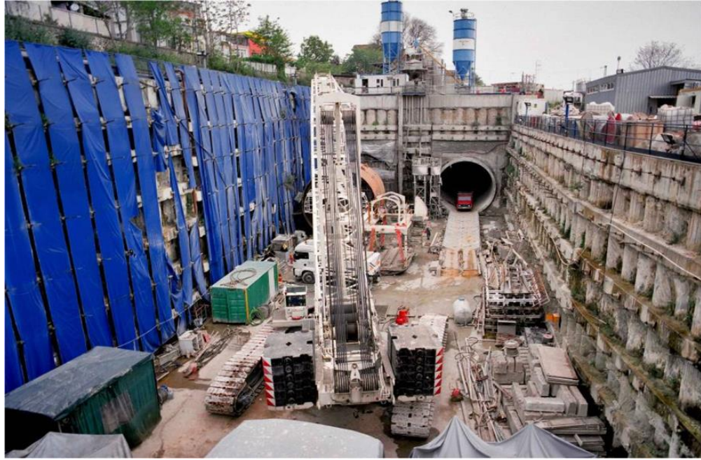
Şekil 4.2: TBM Tünellerine Genel Bakış.
