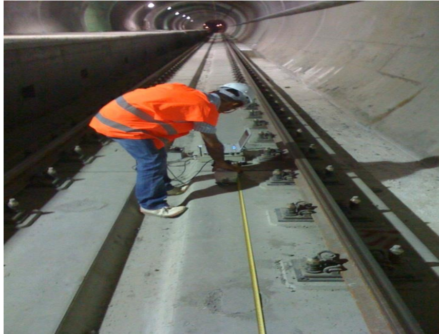
Şekil 4.10: Tünel içi GPR yöntemiyle veri toplama çalışmaları.
