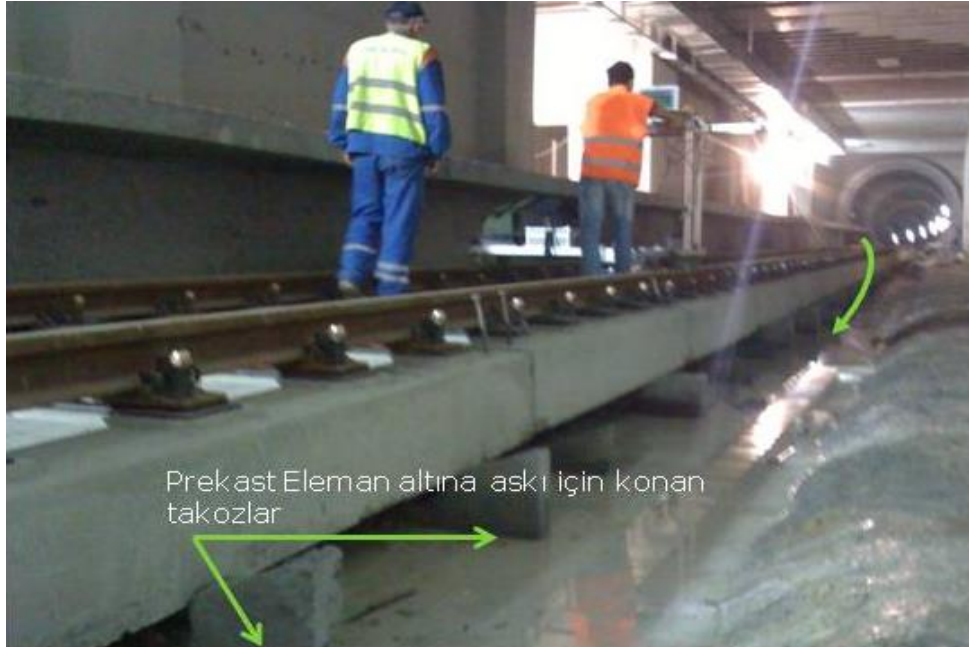
Şekil 4.9: Tünel içerisinde prekast elemanların montajı.
