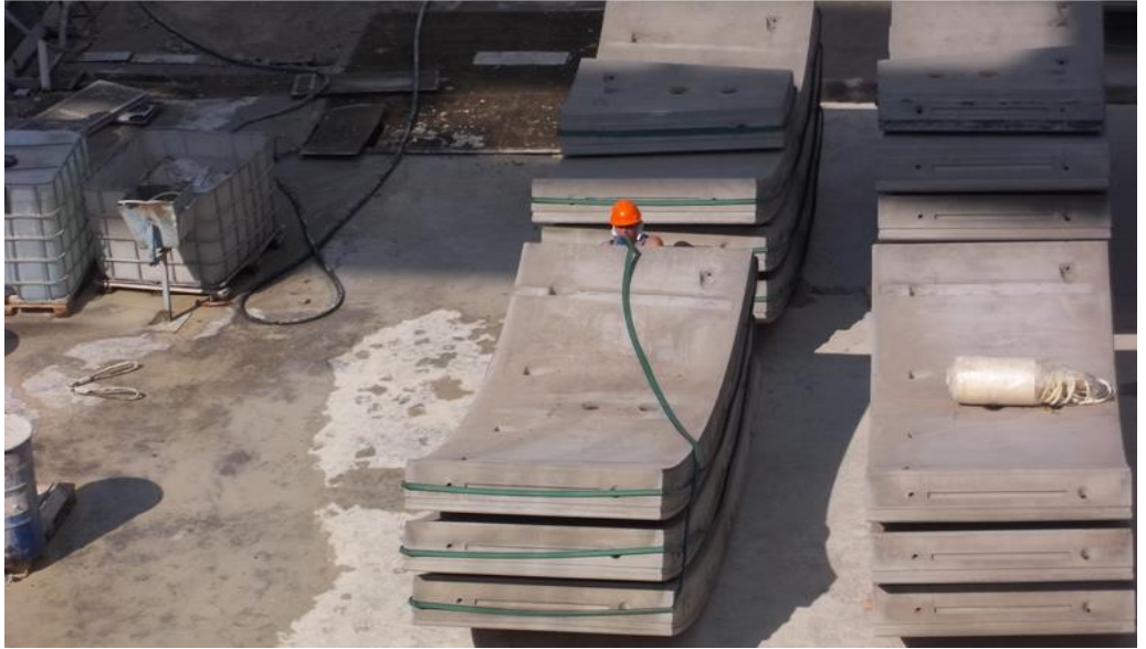
Şekil 4.4: Segmentlerin kenarlarına yapılan contalama işlemi.
