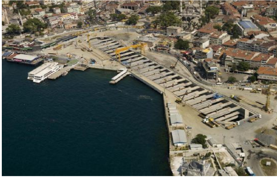
Şekil 2.2: Üsküdar İstasyonu Aç-Kapa Tüneli ( www.marmaray.com.tr ).
