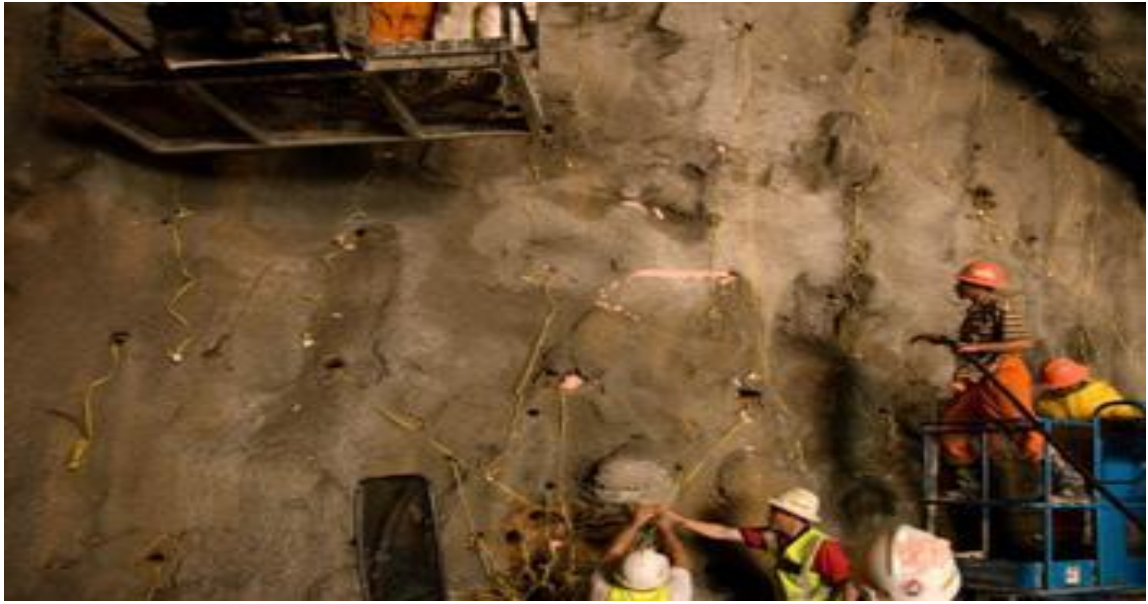
Şekil 2.3: Deliklere patlayıcı yerleştirilmesi ( http://delmepatlatma.org/tunel-acma-syfdty-97.html ).
