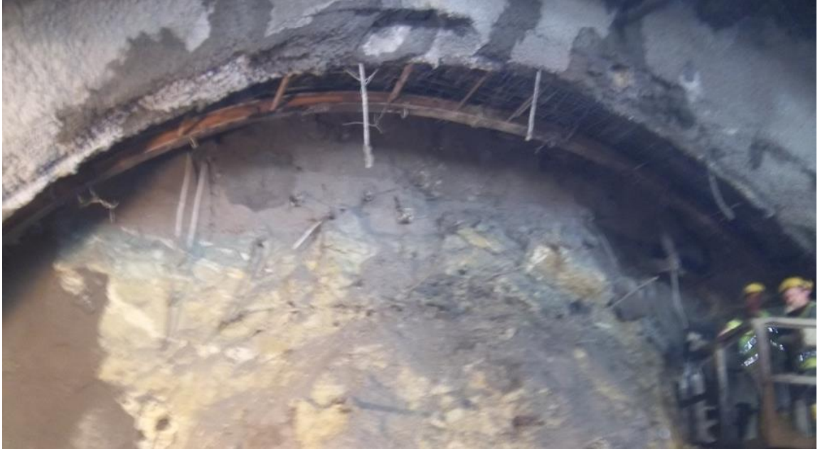
Şekil 2.11: Marmaray Projesi-Yenikapı Turnback Tüneli-Çelik iksa montajı (Ergüven, 2011)
