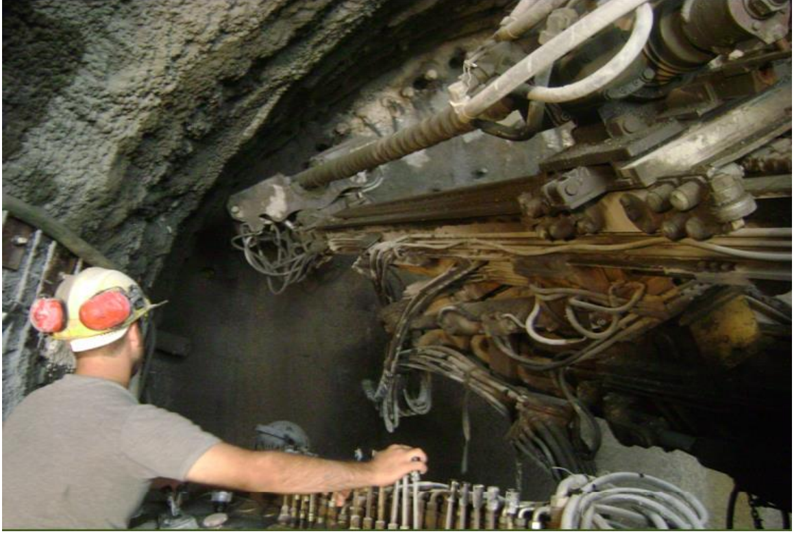
Şekil 2.14: Marmaray projesi-Yenikapı Turnback Tüneli- “Auger” vasıtasıyla Umbrella Delgisinin yapılması (Ergüven, 2011).
