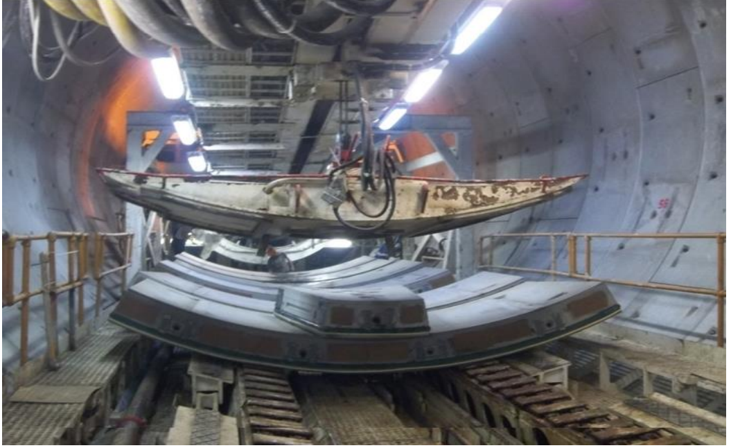
Şekil 4.3: Hidrolik erektör yardımıyla tüneli oluşturan segmentlerin dizimi.
