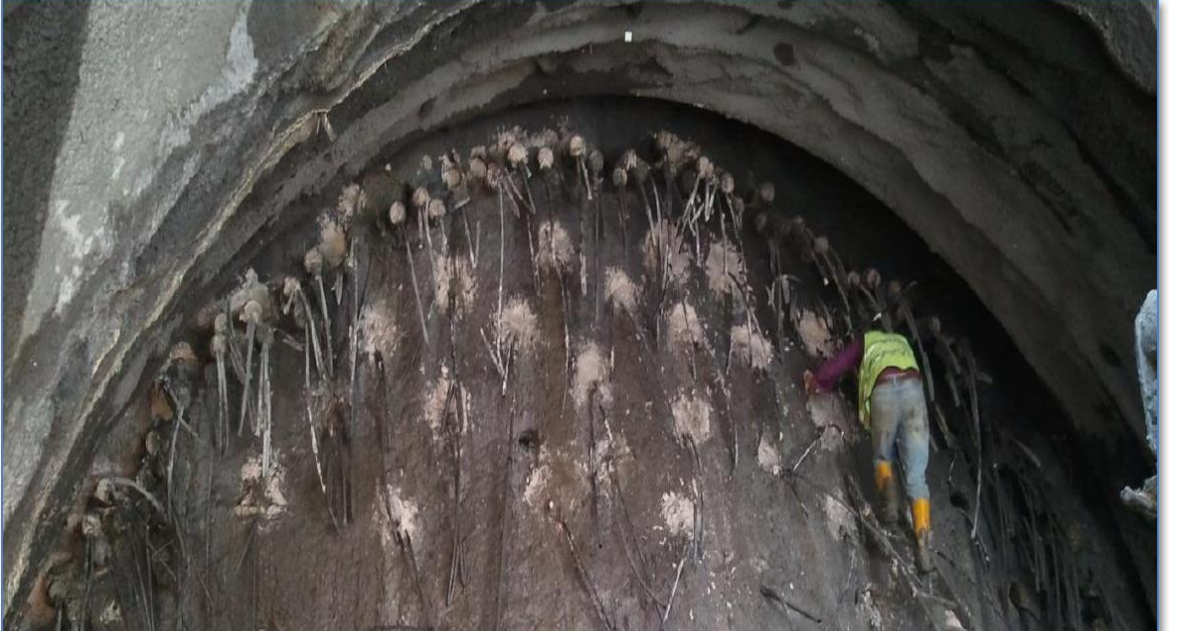
Şekil 2.12: Marmaray Projesi-Yenikapı Turnback Tüneli-Şemsiye Boruları ve Ayna Çivileri (Ergüven, 2011).
