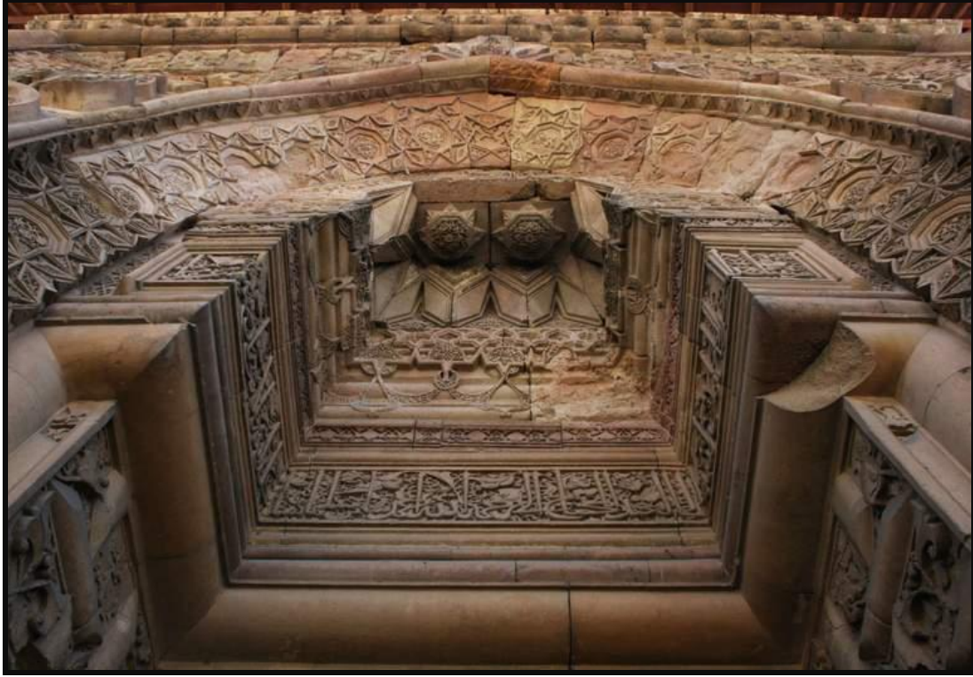
Şekil 7. Kuzey taş kapısı sarkıtlarının ve kitabenin alttan görünüşü (Kurban, 2003)
