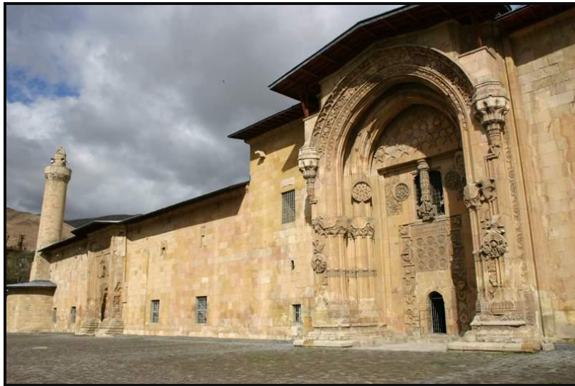
Şekil 3. Divriği Ulu Camisi ve Şifahanesinin batı cephesinden bir görünüş (Kurban, 2003)
