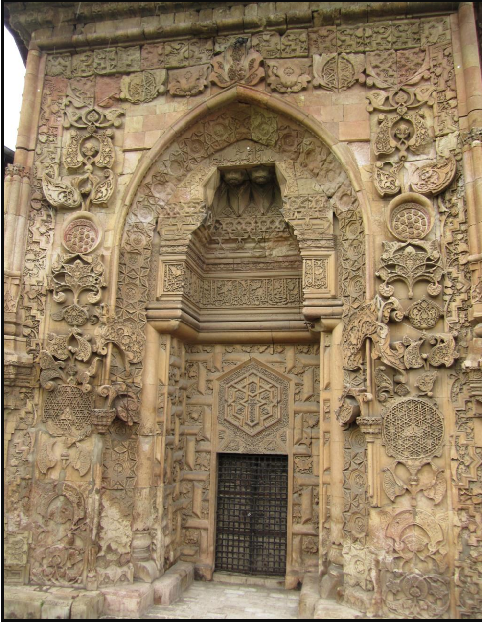
Şekil 6. Kuzey taç kapısından bir görünüş
