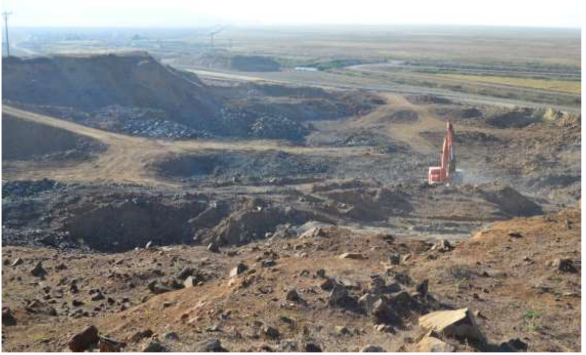
Şekil 4.13. DSİ İpsala Koyuntepe Malzeme Ocakları, İpsala, Koyuntepe (21.10.2014).
