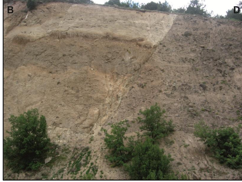
Şekil 3.31 Yerkuyu Köyü güneyinde Mamak formasyonunu kesen 8 numaralı fay (Konum için şekil 3.13'e bakınız)
