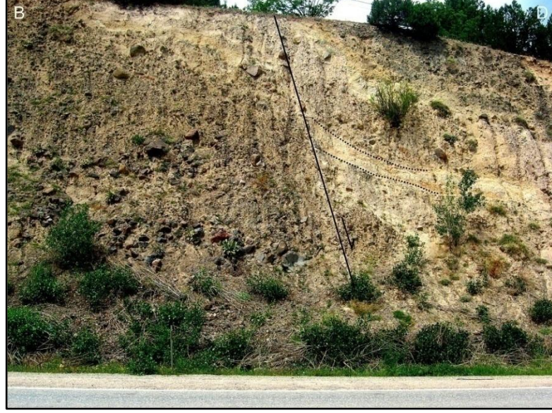
Şekil 3.27 Yerkuyu Köyü güneyinde Mamak formasyonunu kesen 4 numaralı fay (Konum için şekil 3.13'e bakınız)
