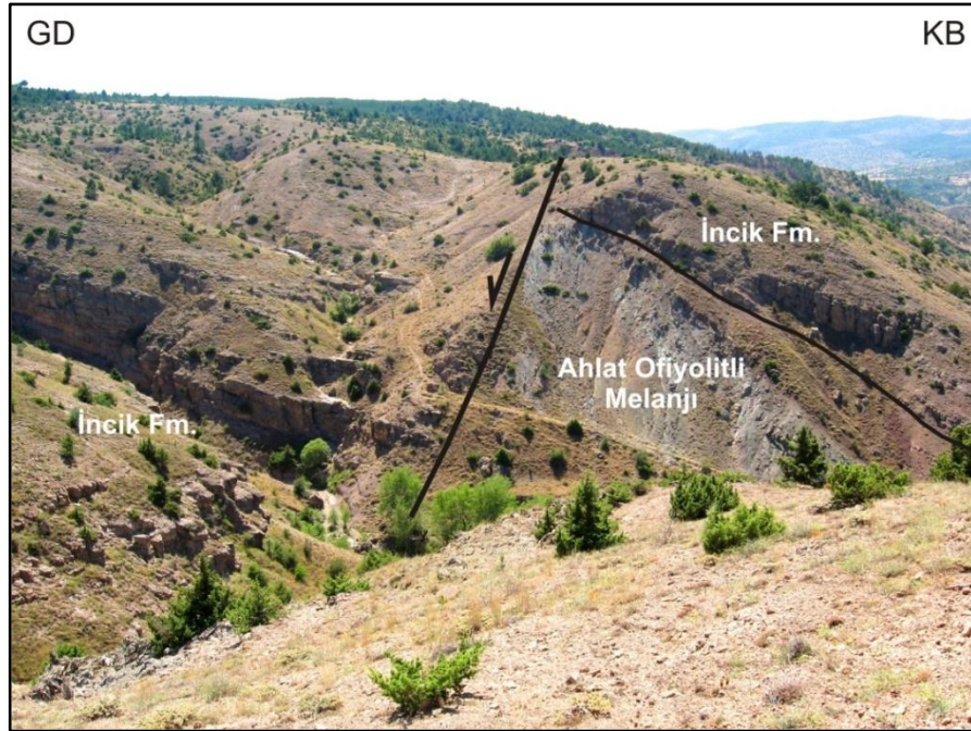
Şekil 2.58 Kıyısın Köyü güneyinde ofiyolit ile İncik formasyonu arasındaki normal faylı dokanak (Konum için şekil 2.54'e bakınız)
