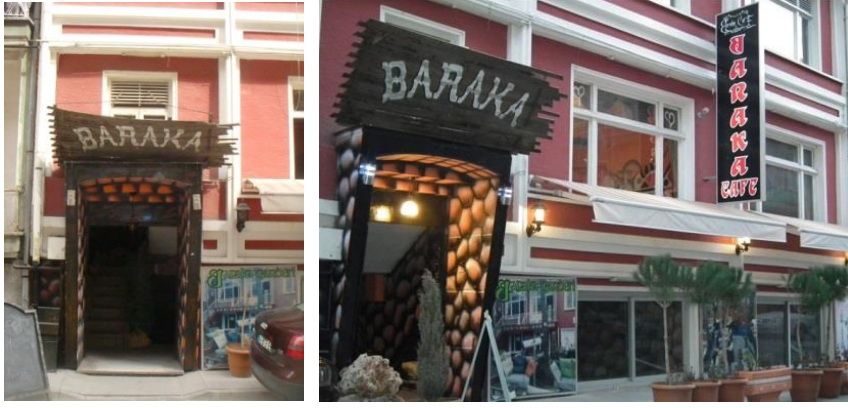
Resim 4.22. Yurdal Apartmanı ön cephe ve giriş 1
