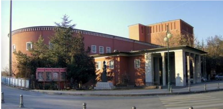
Resim 2.1. Ankara Opera Binası. ( www.mimdap.org )
