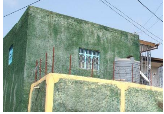
Resim 5.8: çimento sıva uygulamis duvar (Marianbeth, 16 temmuz 2013)
