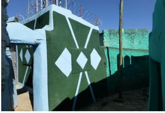
Resim 5.7: çimento sıva uygulamis duvar (LeonoraChristinaSkov, Aralık 2013)
