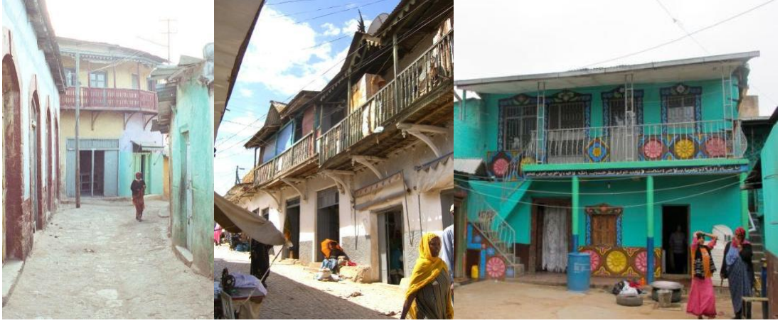
Resim 5.16: Harar geleneksel evlerinde eksikliği olan, hasarlanmış ve demir ile değiştirilmiş korkuluklar (tripadvisor.com, Aug 2009, tripadvisor.com, Eylül 2009 ve Marianbeth, 16 temmuz 2013)
