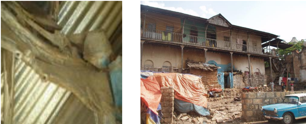
Resim 5.15: Harar geleneksel evlerinde hasarlanmış deranj yapıları (AbdAllah , Mart 2009 ve doumechris, Ekim 2008)
