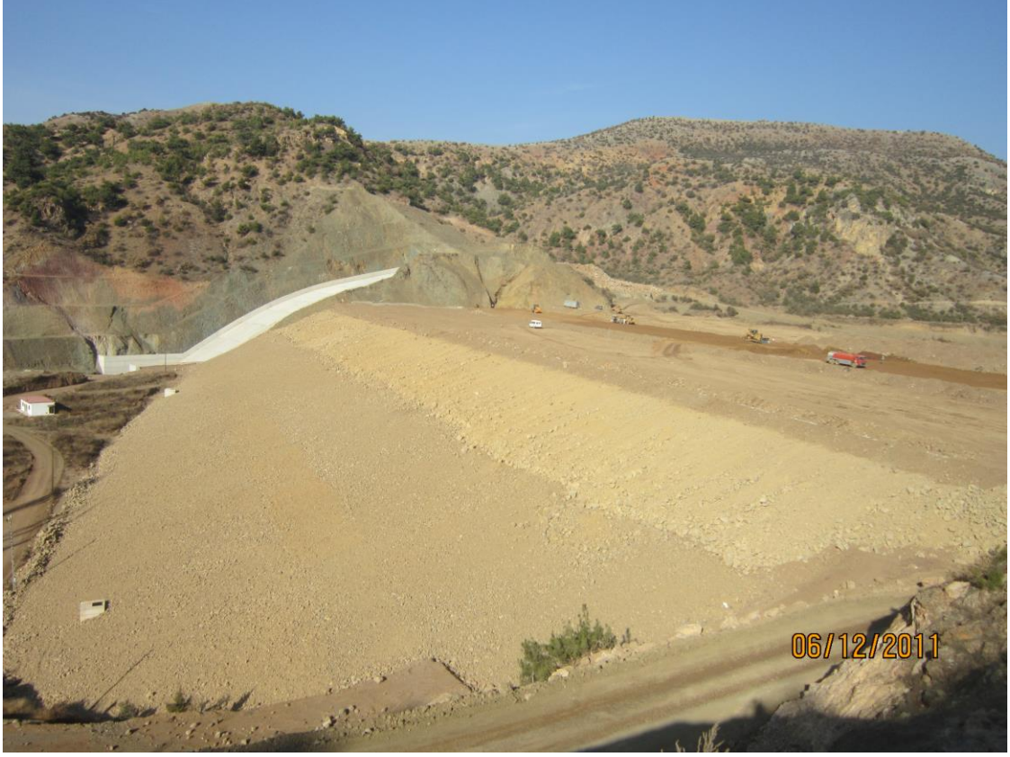
Şekil 4.2. Gövde Dolgu Çalışmaları
