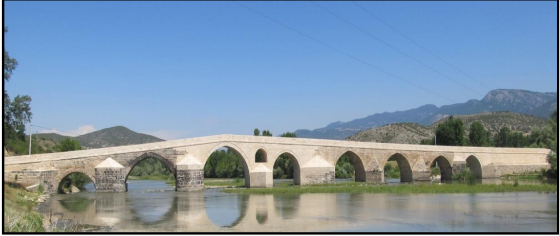
Fotoğraf 2.25. Talazan Köprüsü
