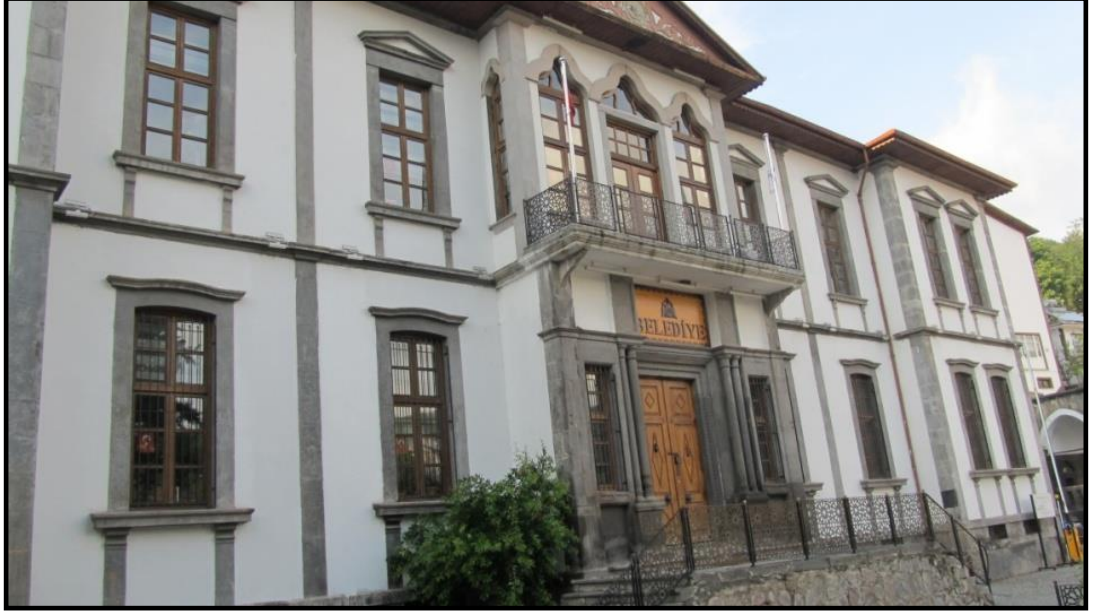
Fotoğraf 2.35. Eski Hükümet Konağı
