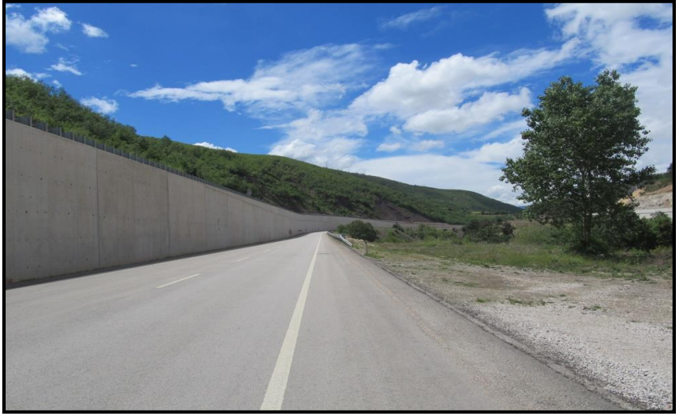
Fotoğraf 2.45. Kelkit Vadisi'nin Dar Kısımlarında Taraçalar Halinde Yapılmış D-100 Karayolu
