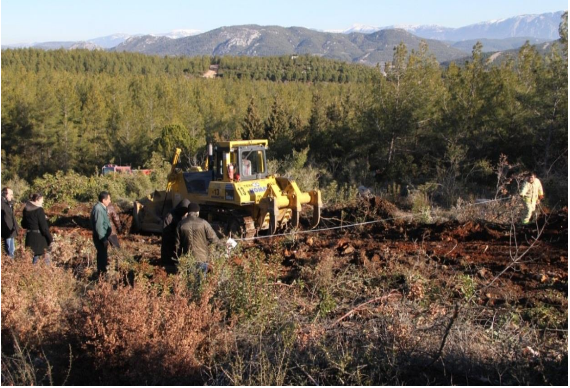
Şekil 45: Dozer ile yol yapımı.
