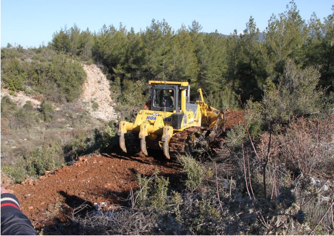
Şekil 49: Dozerle B tipi orman yolu yapımı.
