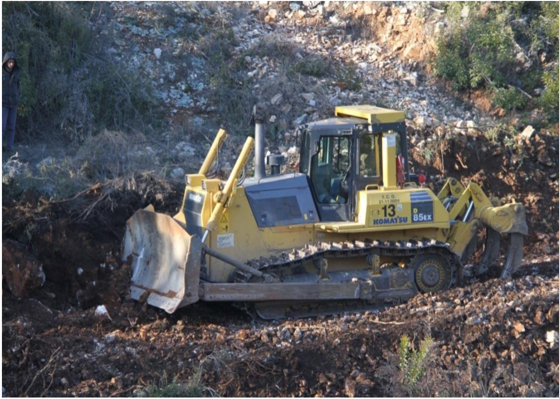
Şekil 44: Dozerle şerit açılması.
