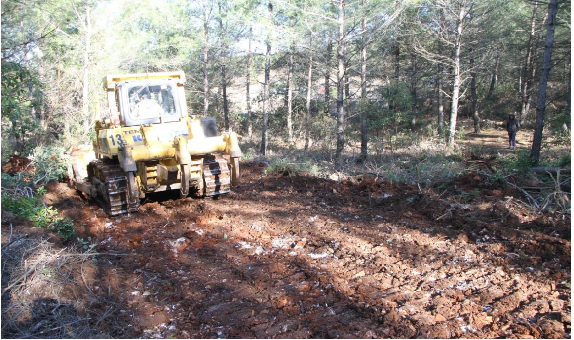
Şekil 48: Dozerle yangın emniyet yolu yapımı.
