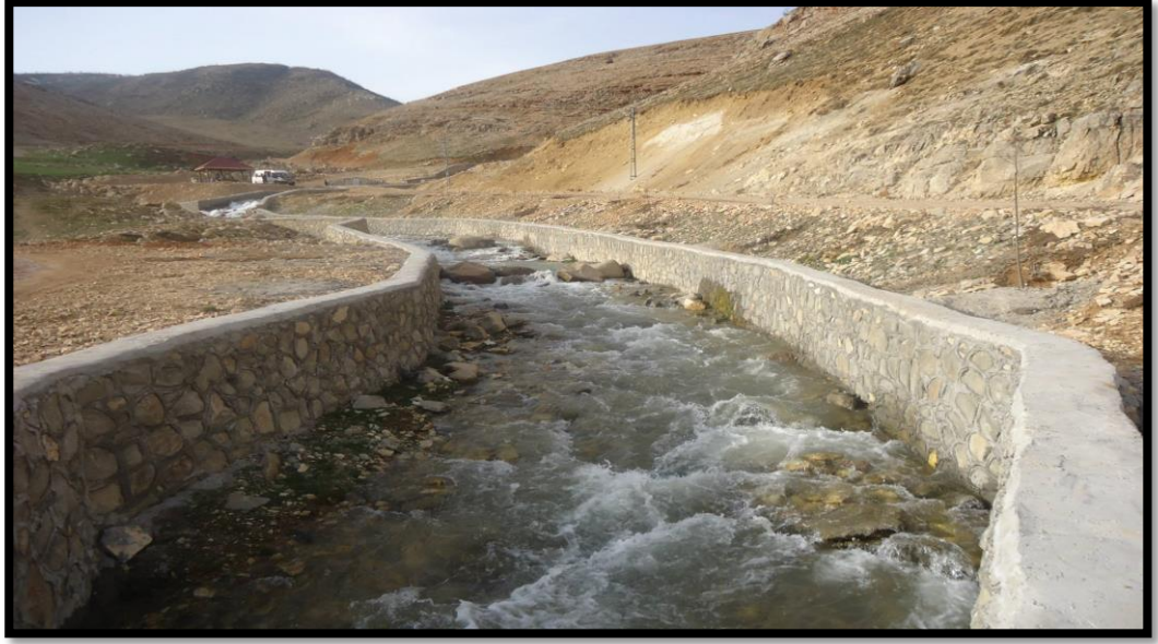
Fotoğraf 3. Hozat Deresi'nin (Singeç Çayı ) kaynak (Göze) kısmı ve yatağı boyunca taşkınları önlemek için yapılan kanal
