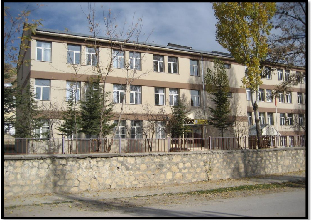
Fotoğraf 7. Hozat ilçe merkezinde Hamidiye Mahallesi'nde bulunan Zübeyde Hanım Lisesi'nden bir görünüm
