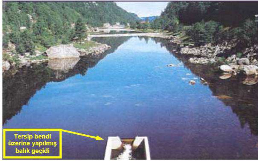
Şekil 3.24:Tersip bentlerinden sonraki dere yatağının aldığı görünüm.
