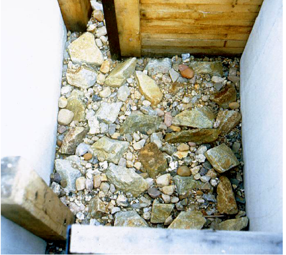
Şekil 2.18: Yarıklı geçitte kaba malzemeli substrat; unterspreewald'deki (brandenburg) aşağı puhlstrom bendi.
