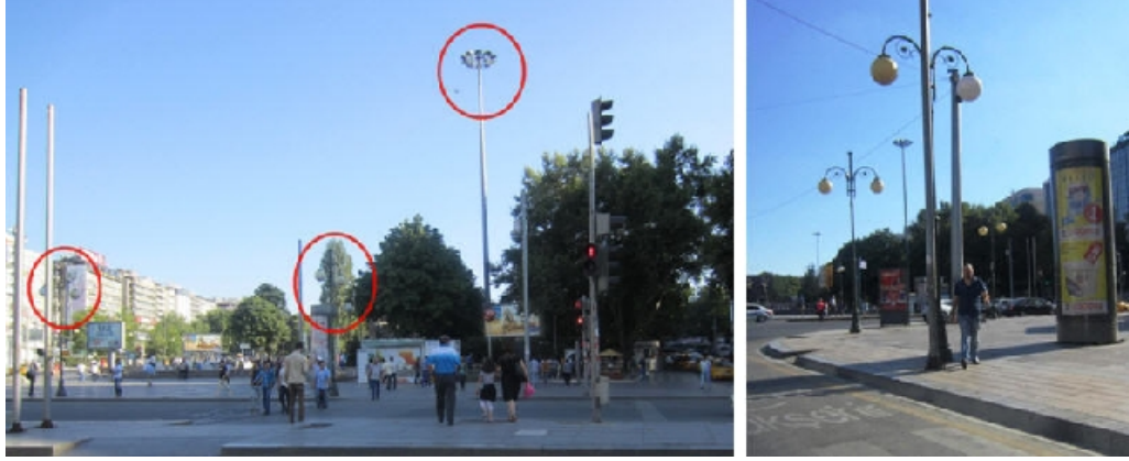
Resim 85. Kızılay Meydanı Kavşak Tipi Çoklu ve Sokak Tipi İkili Aydınlatma Elemanları
