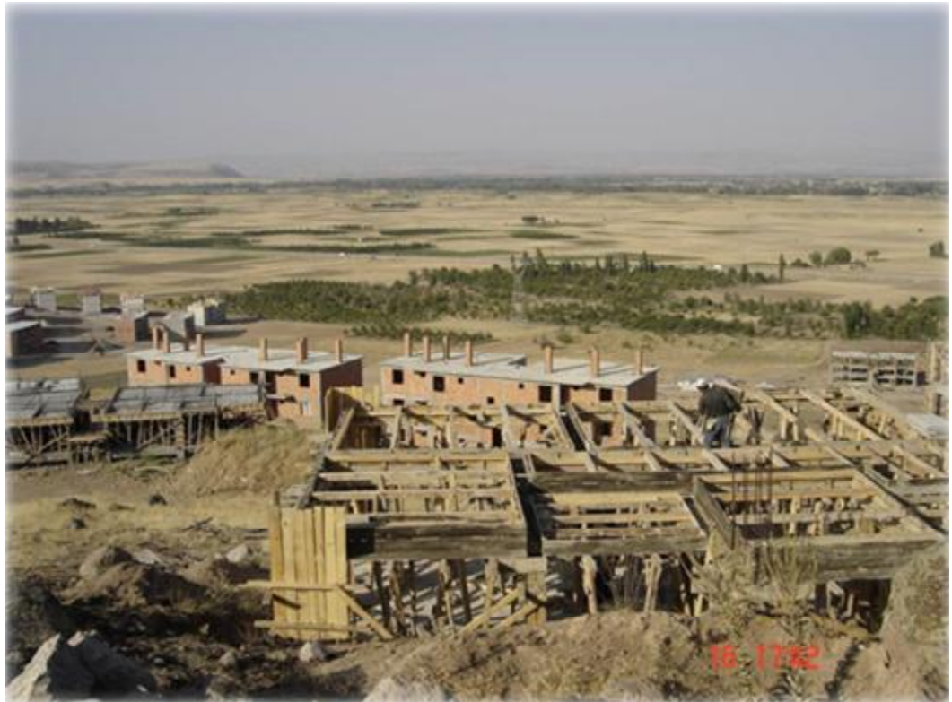
Şekil 2.6. Afyonkarahisar kalıcı konutlar inşaat aşaması (2006)
