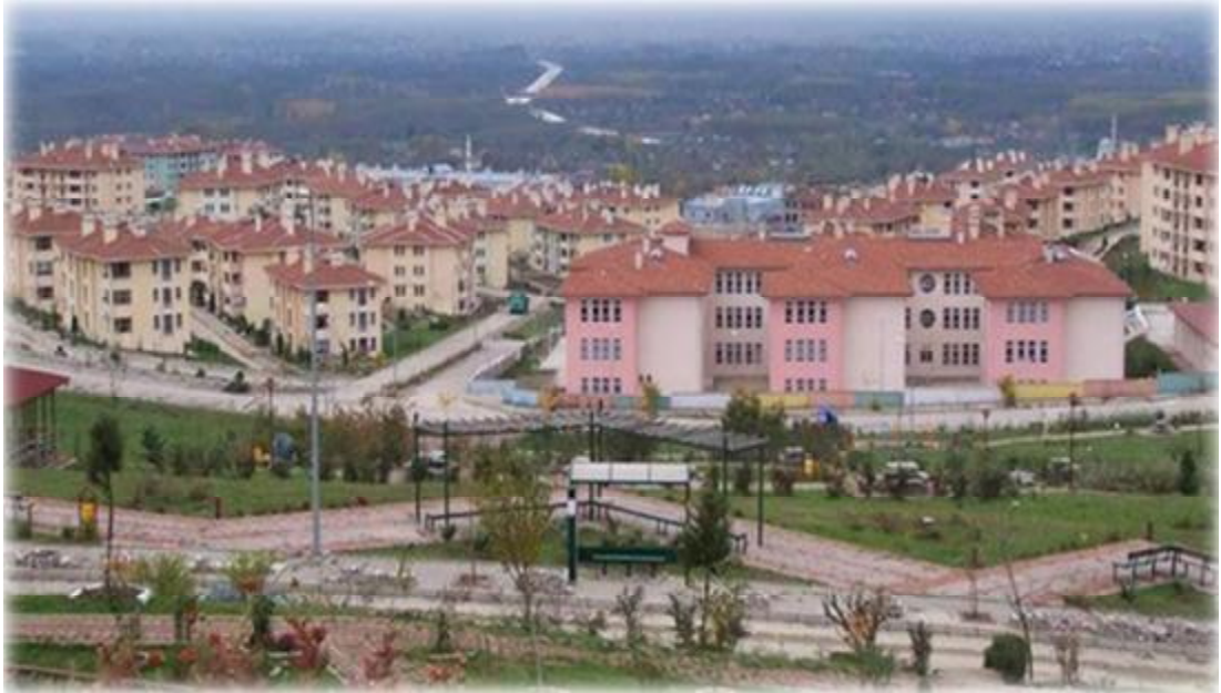
Şekil 2.1. Sakarya-Karamanköy kalıcı konutları
