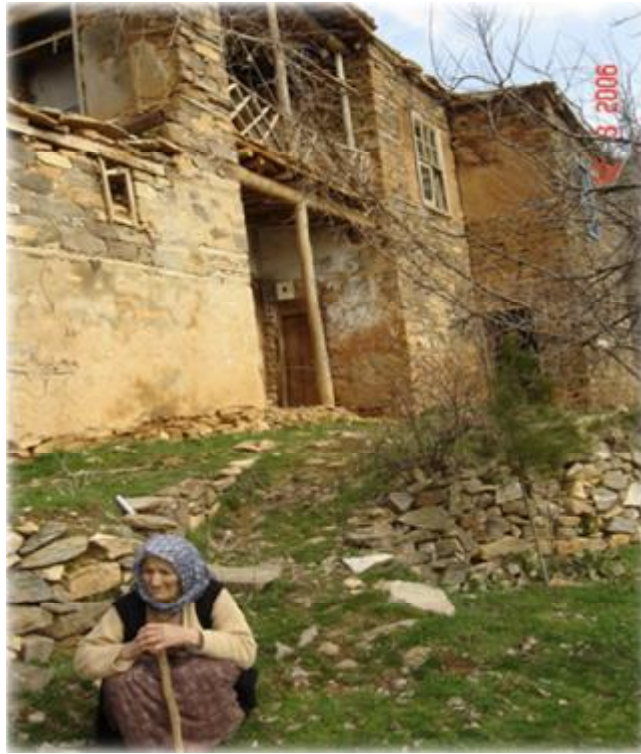
Şekil 4.8. Malatya-Pütürge ağır hasarlı köy konutu
