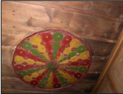
Şekil 4.13 İç mekan tavan detayı
