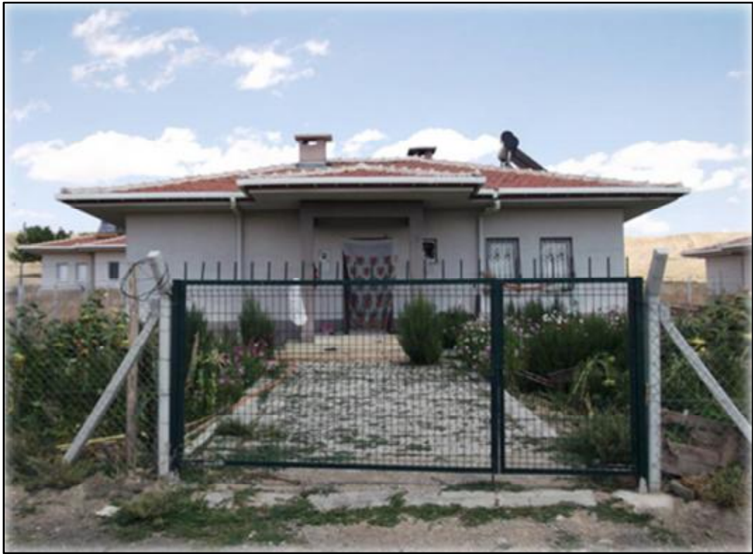
Şekil 4.19. Deprem konutu giriş görünümü
