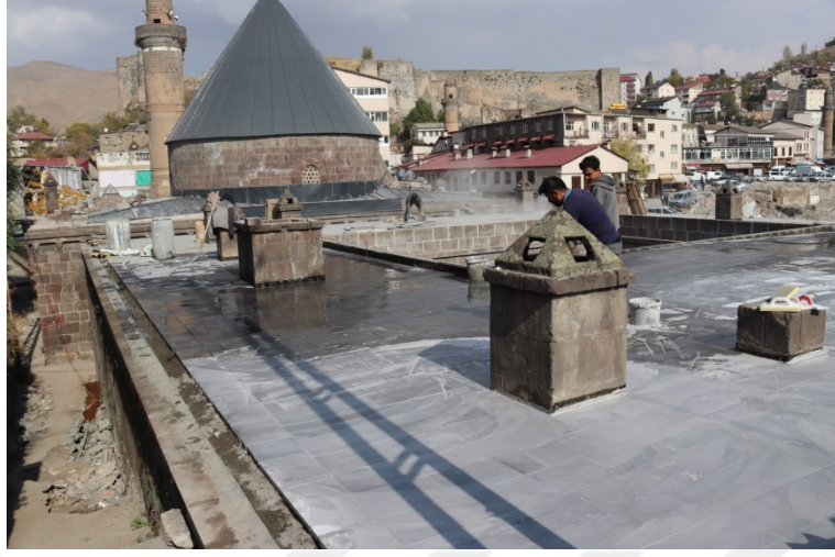
Görsel 24: Örnek No:1-Şerefiye Medresesi Dam Örtüsü Restorasyonu 2021
