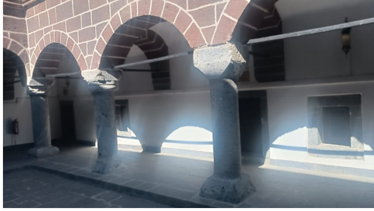
Görsel 147: Örnek No:8-Meydan Medresesi Zemin Kat Revak 2024
