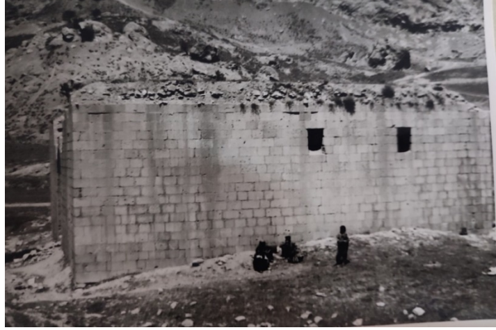
Görsel 132: Örnek No:8-Meydan Medresesi Doğu Cephesi Onarımdan Önce 1982 (VKVKBK Arşivi)
