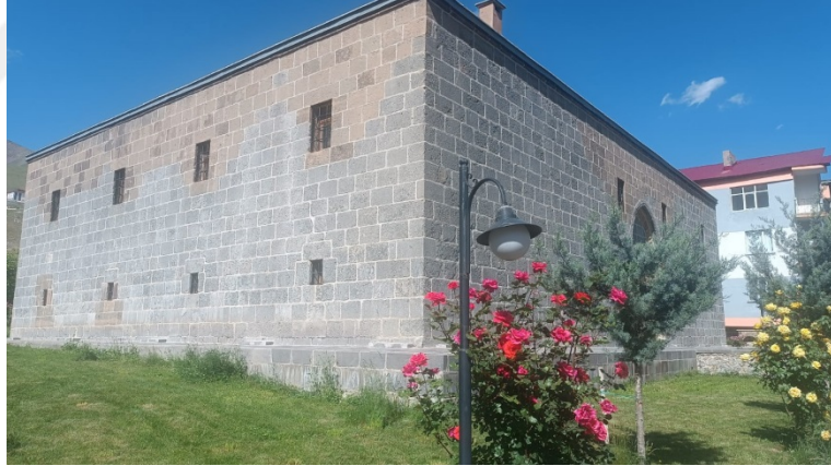
Görsel 128: Örnek No:8-Meydan Medresesi Güneybatı Cephesi 2024
