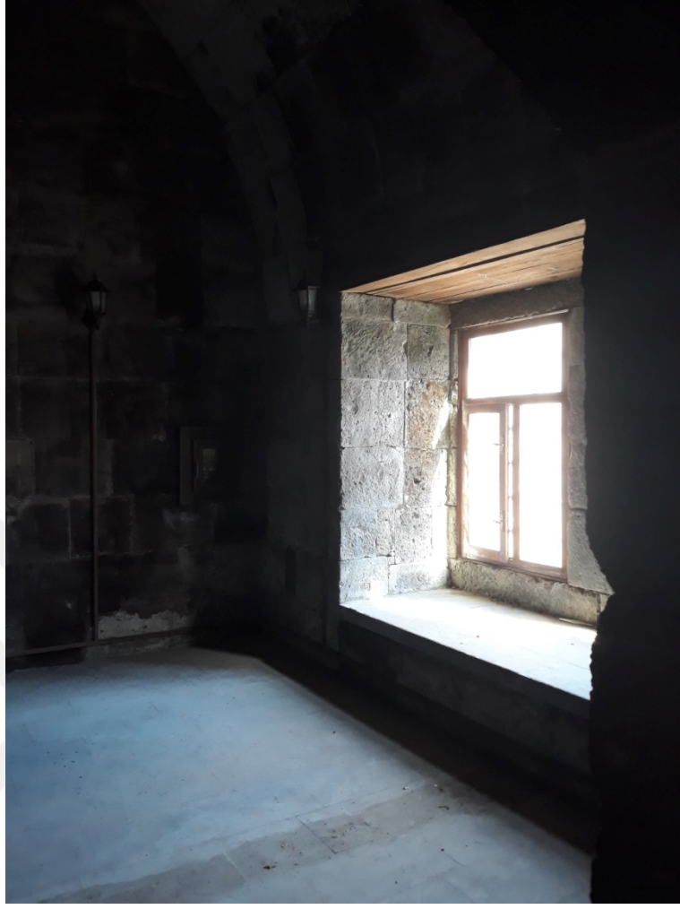
Görsel 43: Örnek No:2-Hatıbiye Medresesi Dershane Hücre Duvarları ve Penceresi 2024
