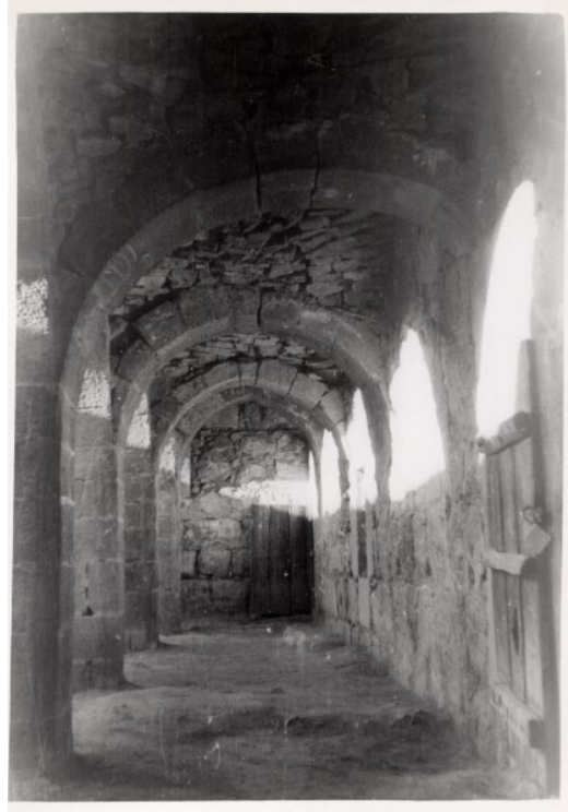
Görsel 153: Örnek No:8-Meydan Medresesi Birinci Kat Revakları1960 (Saim ÜLGEN Arşivi)
