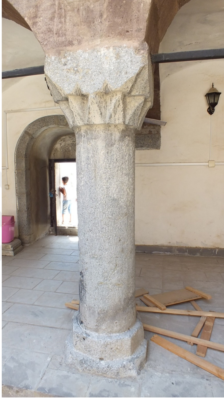
Görsel 138: Örnek No:8-Meydan Medresesi Zemin Kat Revak Sütunu 2024
