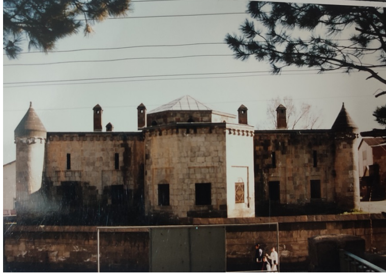
Görsel 57: Örnek No:3-Ihlasiyeh Medresesi Kuzey Cephe 1971 (VKVKBKM Arşivi)
