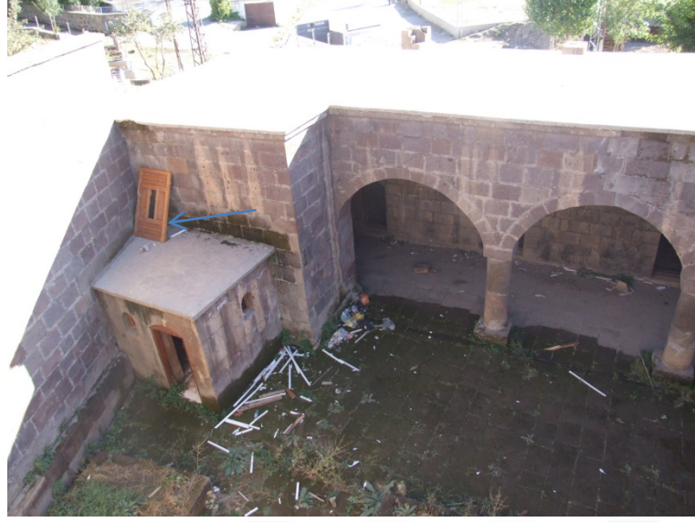
Görsel 74: Örnek No:4-Yusufiye Medresesi Yapıya Sonradan Eklenen Kısım 2024 (Ok ile İşaretlenmiştir)
