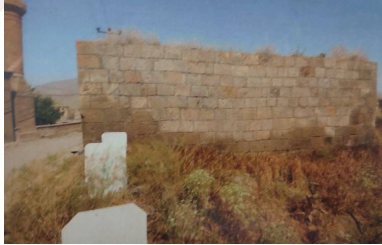
Görsel 168: Örnek No:10-Mollakent Medresesi Batı Cephe
