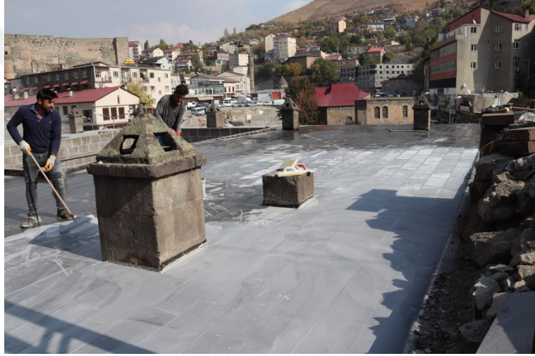
Görsel 25: Örnek No:1-Şerefiye Medresesi Dam Örtüsü Restorasyonu 2021
