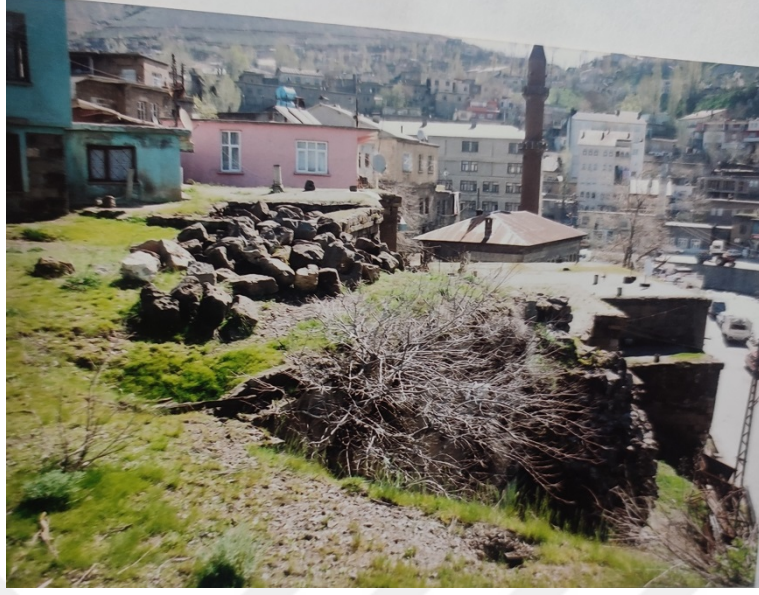
Görsel 33: Örnek No:2-Hatibiye Medresesi Restorasyon Öncesi Toprak Dam Örtüsü (VKVKBKM Arşivi)
