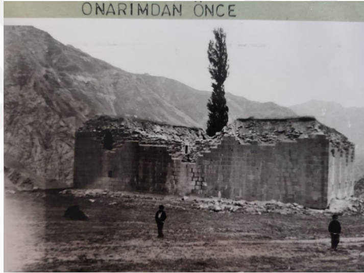
Görsel 133: Örnek No:8-Meydan Medresesi Kuzey Cephesi Onarımdan Önce 1982 (VKVKBK Arşivi)
