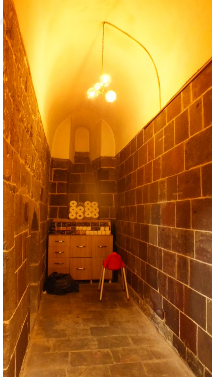
Görsel 20: Örnek No:1-Şerefiye Medresesi Avlu ile Hücre Bağlantısını Sağlayan Beşik Tonozlu Koridor 2024
