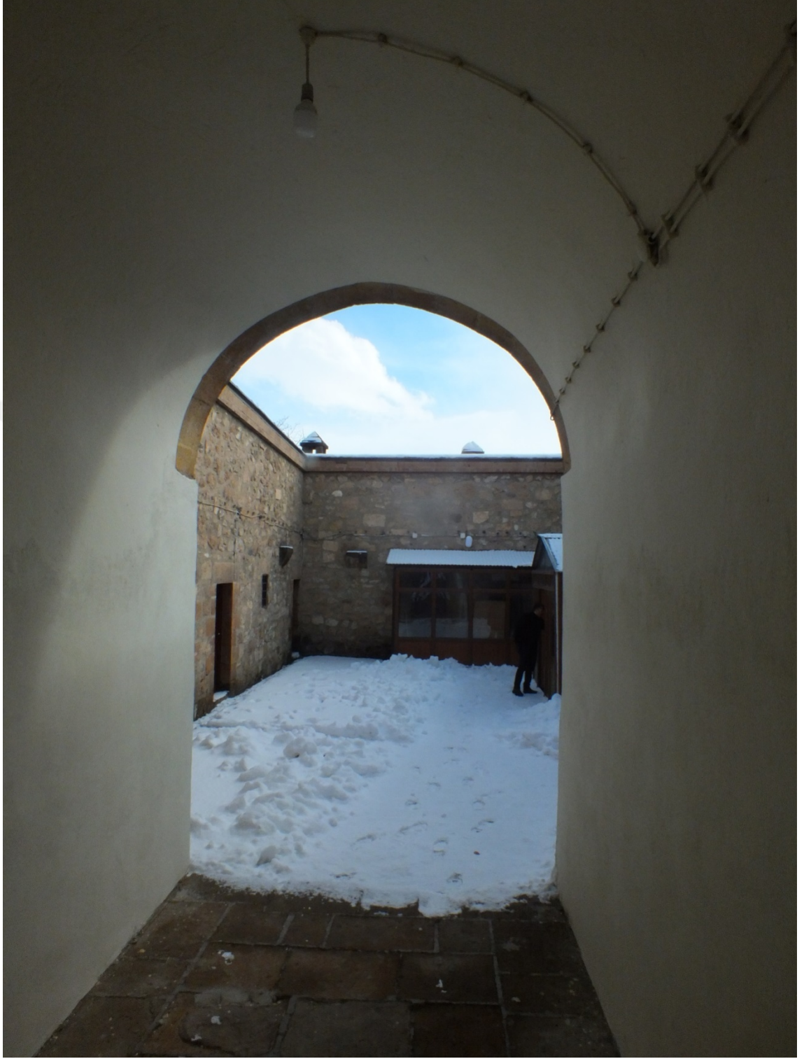
Görsel 229: Örnek No:16-İzeddin Şir Medresesi Taç Kapı Giriş Eyvanından Avlu Görünüşü 2024
