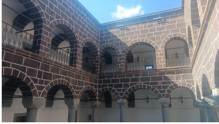
Görsel 135: Örnek No:8-Meydan Medresesi Avlu Restorasyondan Sonra 2024
