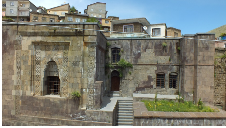
Görsel 28: Örnek No:2-HatibiyeMedresesi Güney Cephe 2024
