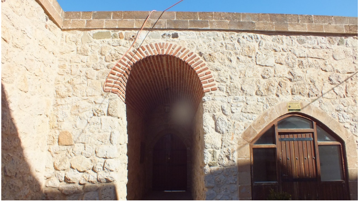
Görsel 208: Örnek No:15-Hüseyin Paşa Medresesi Avluya Geçiş Sağlayan Koridorlardan Biri 2024
