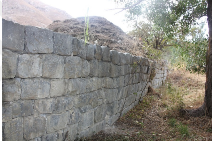
Görsel 108: Örnek No:7-Zeynel Bey Medresesi Batı Cephe Duvarı 2024
