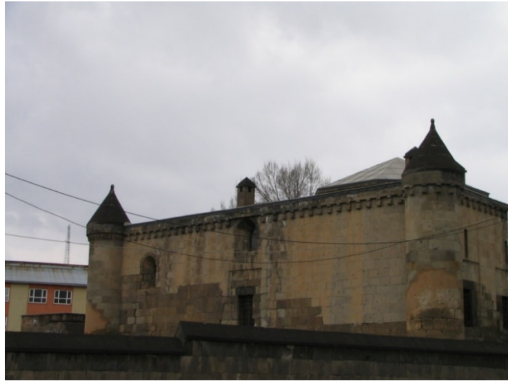
Görsel 50: Örnek No:3-Ihlasîye Medresesi Doğu Cephe 2024
