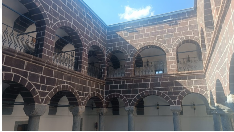
Görsel 148: Örnek No:8-Meydan Medresesi Zemin Kat Revak 2024
