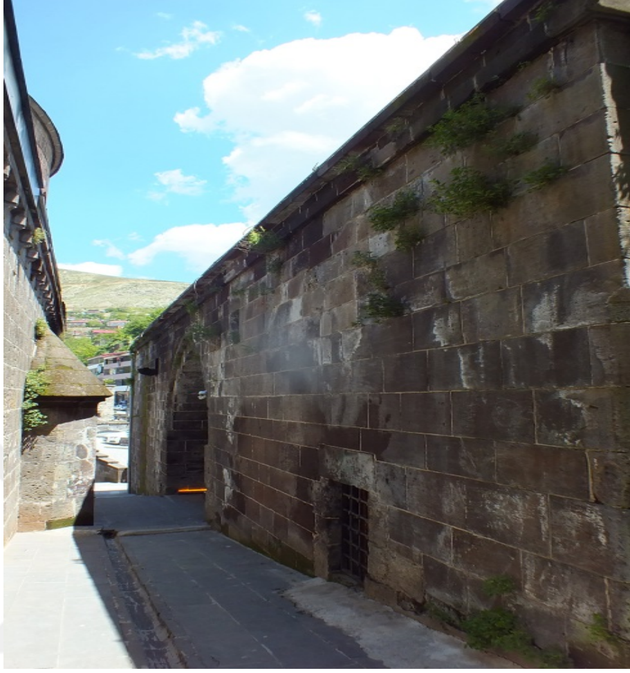
Görsel 11: Örnek No:1-Şerefiye Medresesi Tek Katlı Kuzey Cephe 2024
