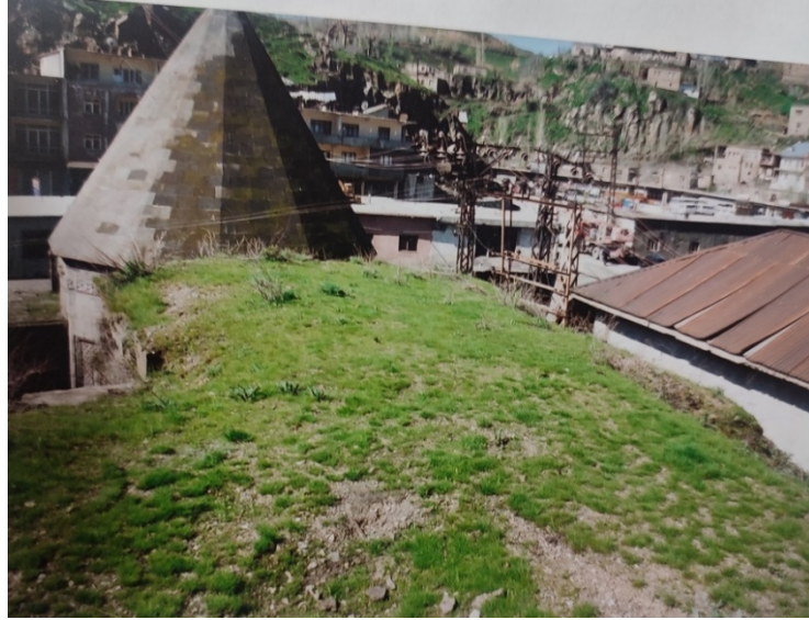
Görsel 32: Örnek No:2-Hatibiye Medresesi Restorasyon Öncesi Toprak Dam Örtüsü (VKVKBKM Arşivi)
