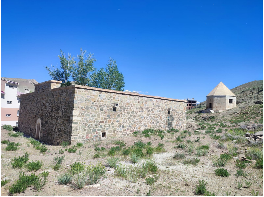
Görsel 261: Örnek No:18-Evliya Bey Medresesi Batı Cephe 2024
