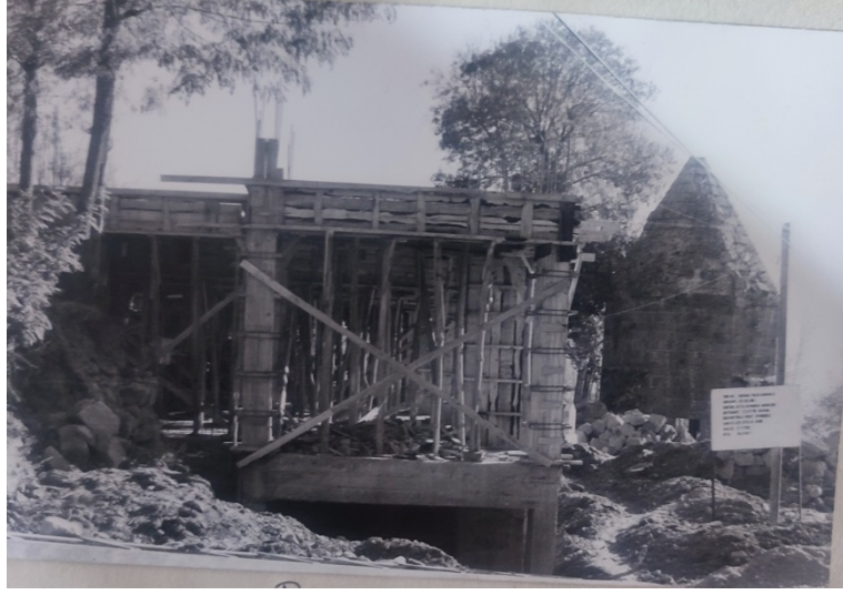
Görsel 99: Örnek No: 5-Nuhiye Medresesi Karakol İnşaatı (KVKBKM Arşivi)
