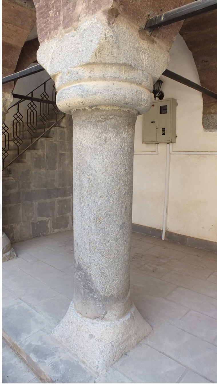
Görsel 139: Örnek No:8-Meydan Medresesi Zemin Kat Revak Sütunu 2024
