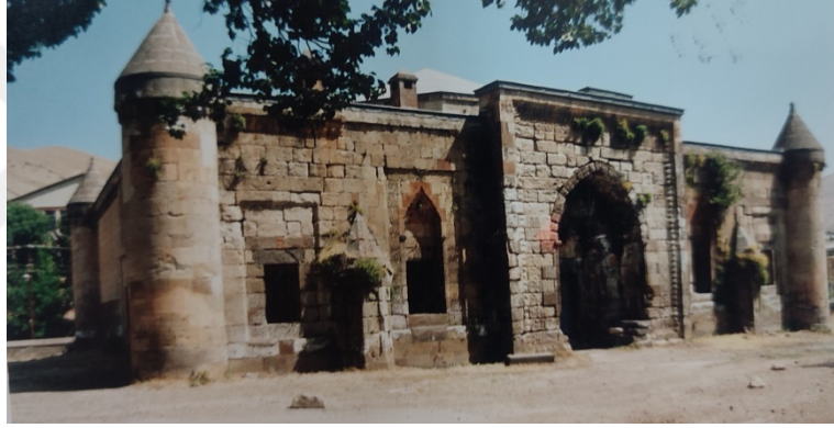
Görsel 58: Örnek No:3-Ihlasiyeh Medresesi Güney Cephe 1971 (VKVKBKM Arşivi)
