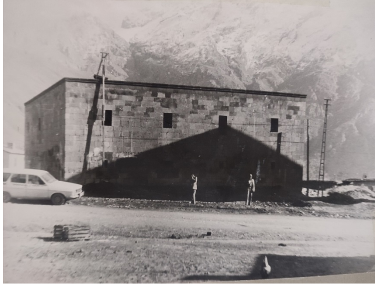
Görsel 131: Örnek No:8-Meydan Medresesi Batı Cephesi Onarımdan Sonra (VKVKBK Arşivi)
