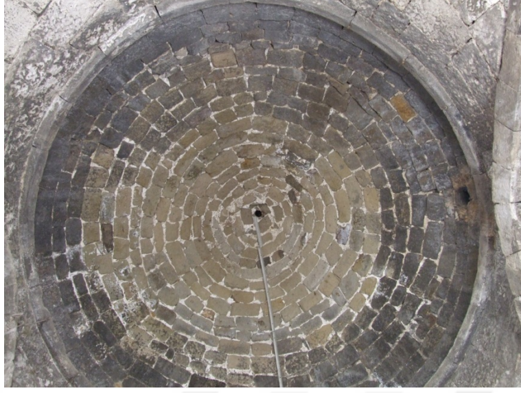
Görsel 90: Örnek No:4-Yusufiye Medresesi Türbe Mekanı Kubbe Üst Örtüsü 2024
