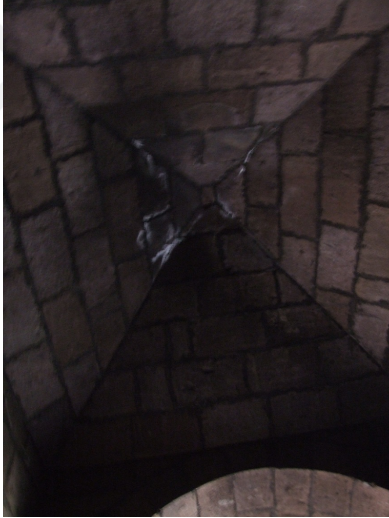
Görsel 87: Örnek No:4-Yusufiye Medresesi Revak Çapraz Tonz Üst Örtü 2024
