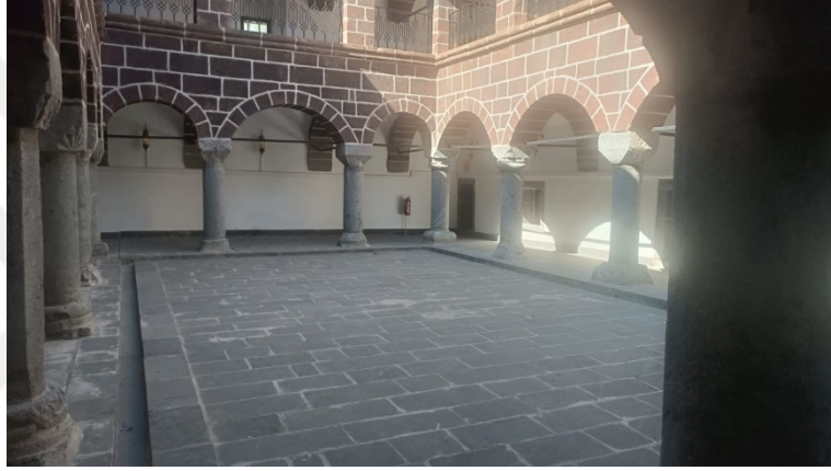
Görsel 136: Örnek No:8-Meydan Medresesi Avlu Restorasyondan Sonra 2024
