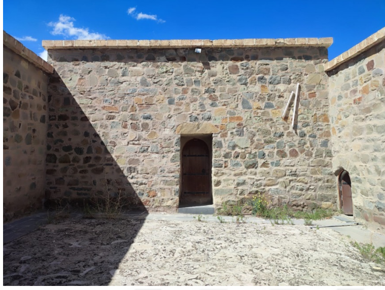
Görsel 189: Örnek No:14-Hasan Bey Medresesi Dershane-Mescit Kapısı 2024
