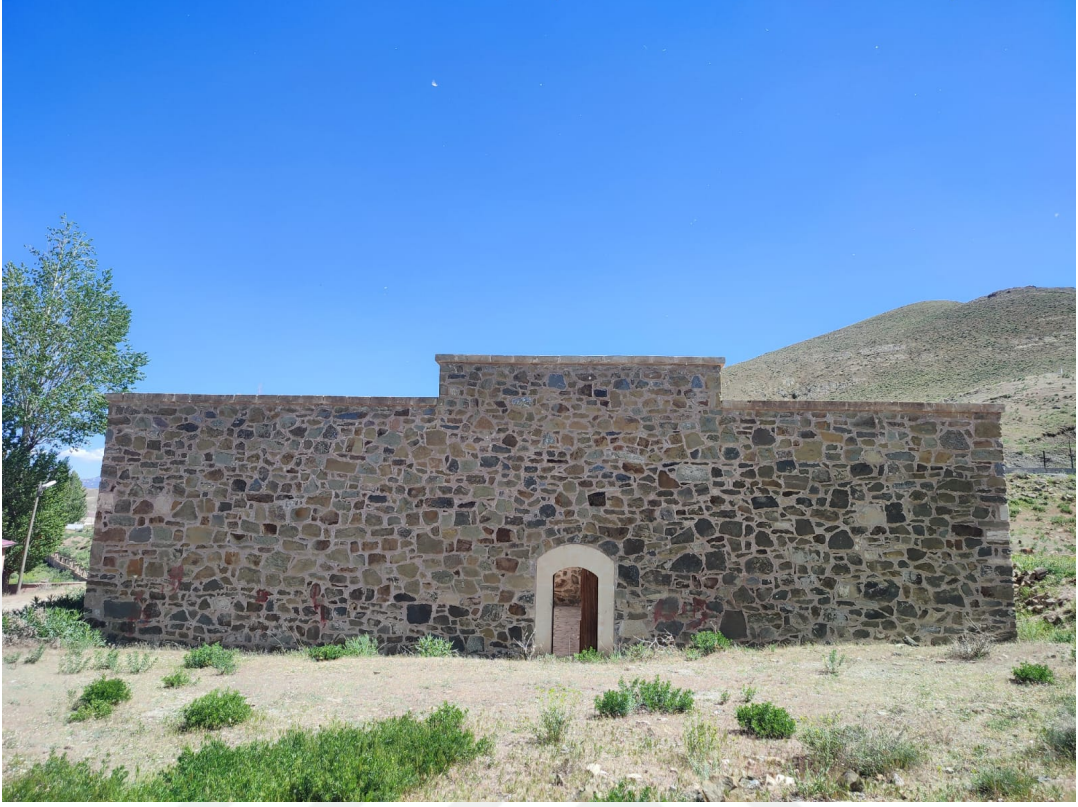
Görsel 259: Örnek No:18-Evliya Bey Medresesi Kuzey Cephe 2024
