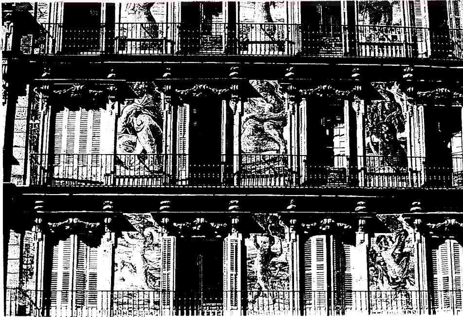
Fotoğraf 8.5.2: Mayor Meydanı'nın Kuzeyindeki Casa de la Pandaria'nın Cephesindeki Freskler [25].
