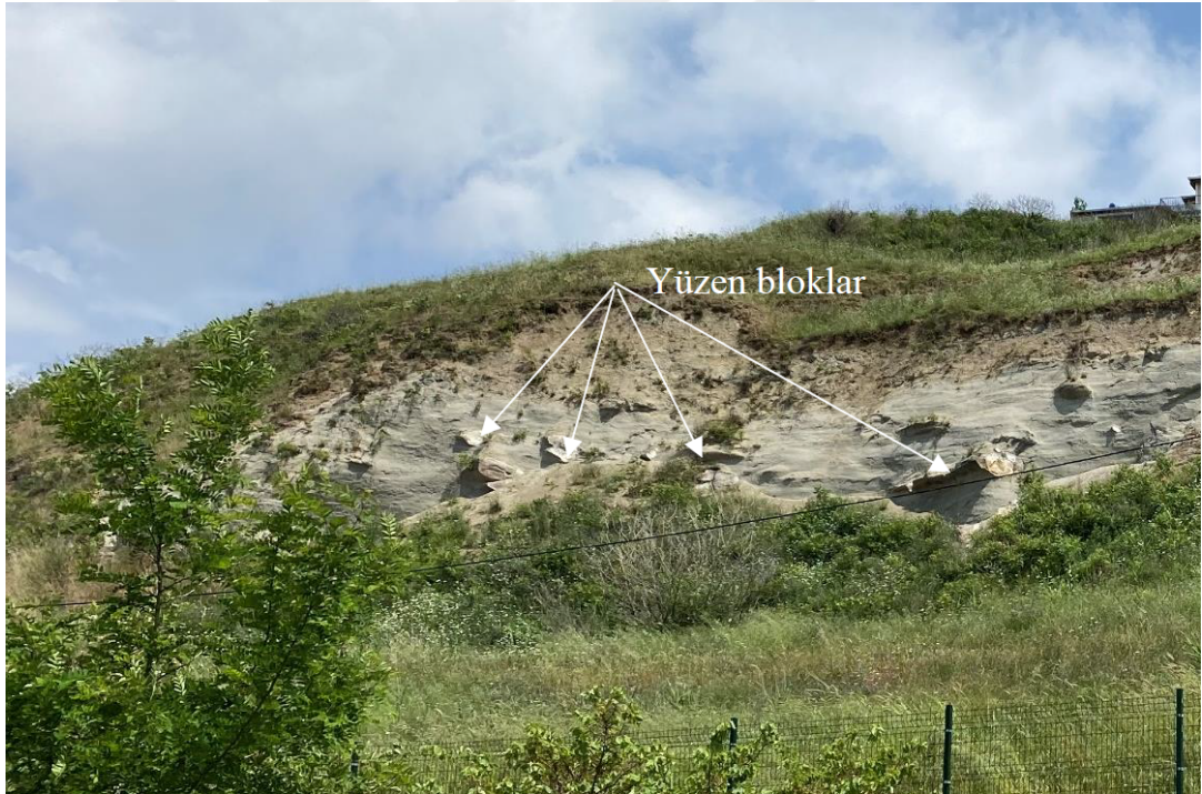
Şekil 7.1 : Pekmez bölgesinde paleoheyelan malzemesi yığını içindeki yüzen köksüz bloklar.
