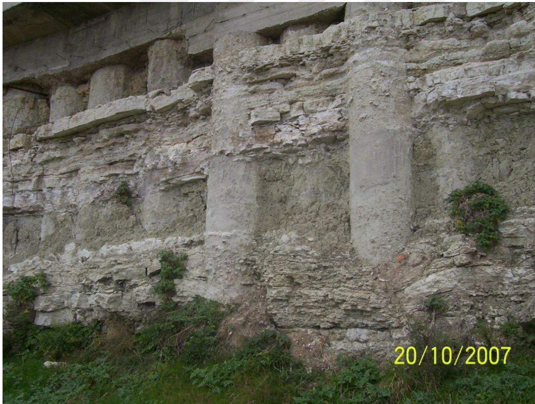
Şekil 2.9 : Avcılar’ da fore-kazık uygulamasının yapıldığı Bakırköy formasyonundan görünüm.
