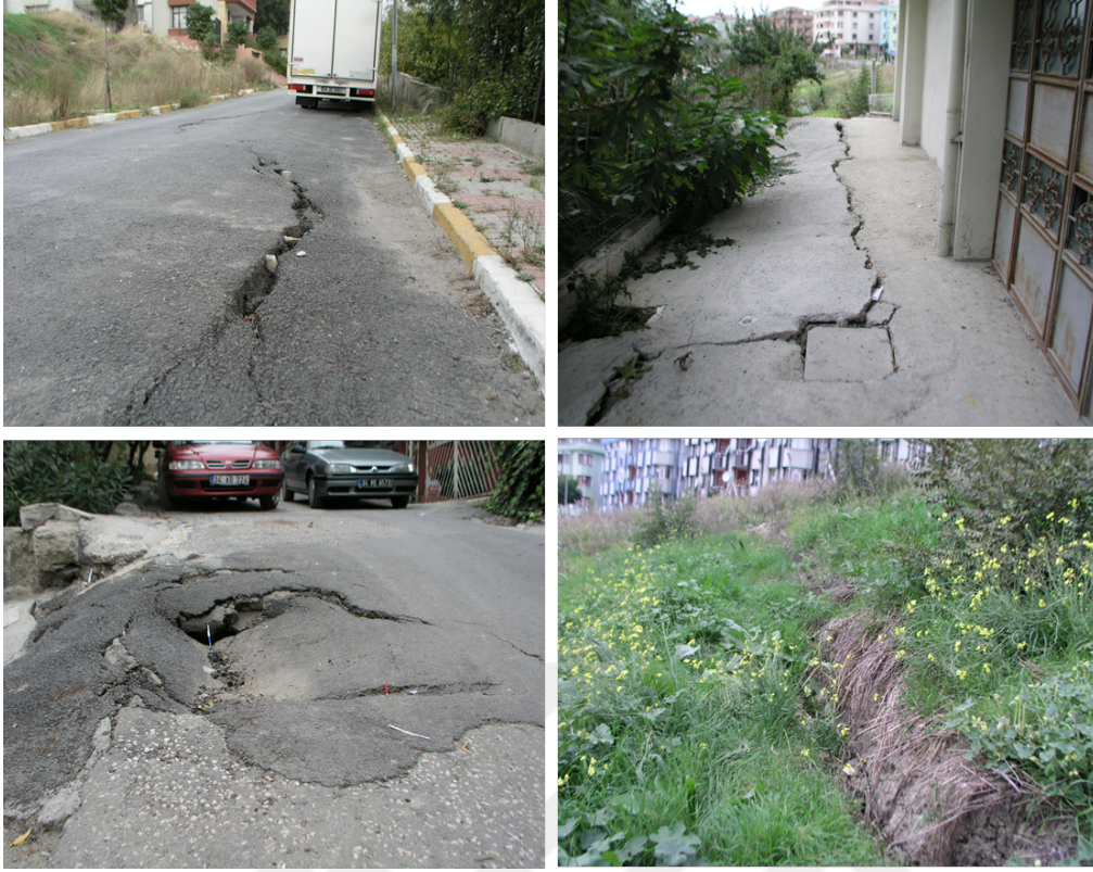
Şekil 6.3 : Ambarlı Mahallesi, Badem Sokak, 2004 tarihli kütle hareketine bağlı deformasyonlar.
