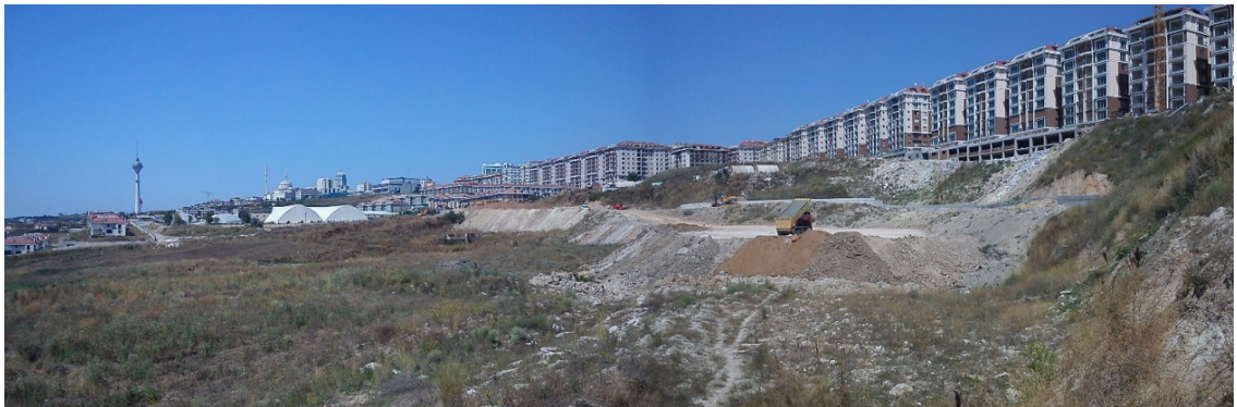
Şekil 6.13 : Beylikdüzü ukurlar heyelan alanınının ta bölgesindeki dolgu alıřmaları (2010).
