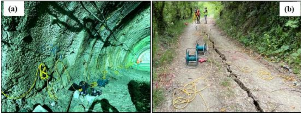
Şekil 24. (a) Tünel yan duvarında (b) tünel üzerinde gerçekleştirilen elektrik özdirenç tomografi ölçümleri
