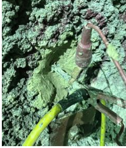
Şekil 23. EÖT’de kullanılan özel üretim elektrotların tünel duvarına yerleştirilmesi
