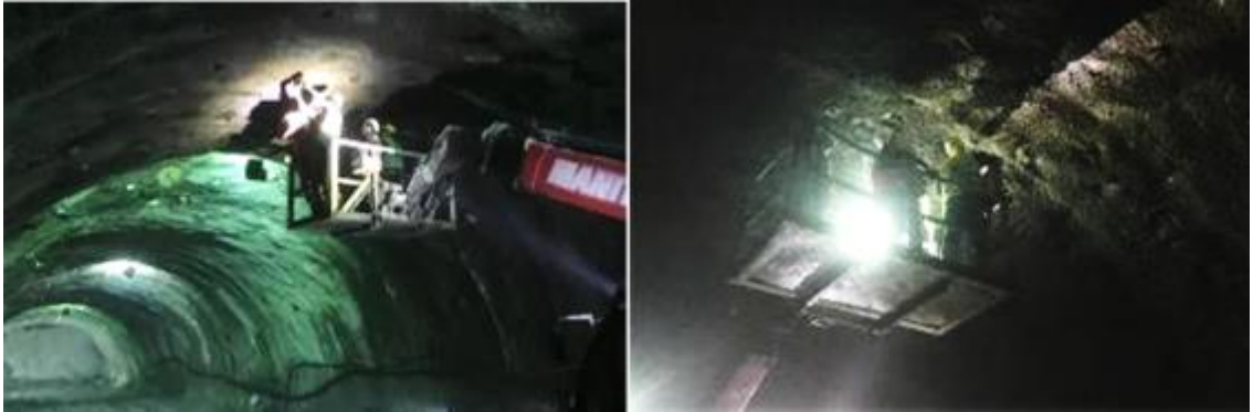
Şekil 21. Tünel içerisinde yapılan yer radarı ölçümleri
