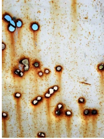
Şekil 3. Boşluk korozyonuna uğramış metal yüzey[12]
