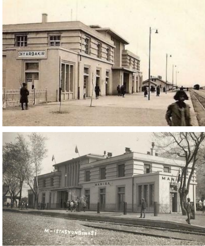
Şekil 1 ve 2. Diyarbakır ve Manisa tren garı binaları (Eski Türkiye Fotoğrafları Arşivi, Salt Araştırma Arşivi).
