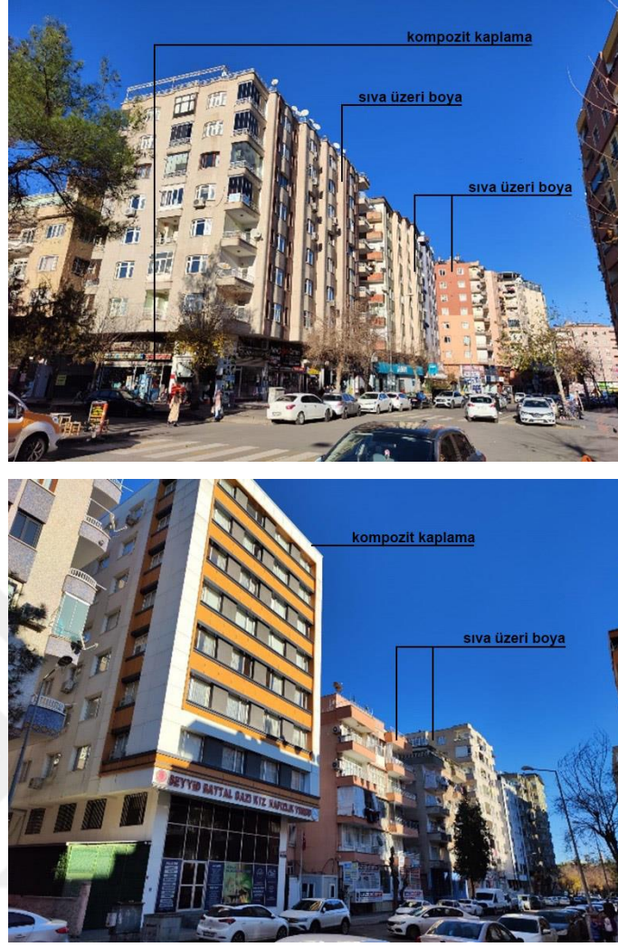
Şekil 63-66. Yenişehir Mahallesi'nden yapı örnekleri.
