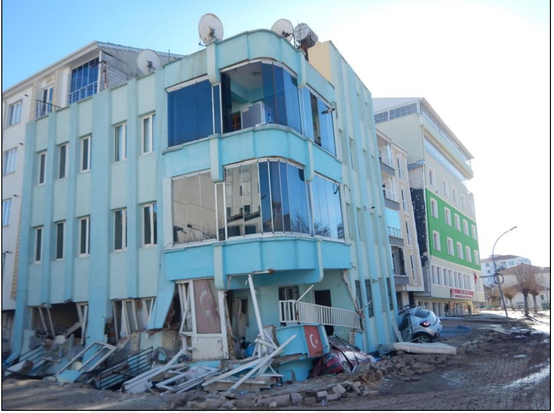
Şekil 7.3: 6 Şubat 2023 Kahramanmaraş depremlerinde sıvılaştıran zemindeki kabarmalar ve oturmalar, binalardaki zemine gömülmeler, düşeyden sapmalar ve yapısal hasarlar (resim Halil Kumsar’dan alınmıştır)
