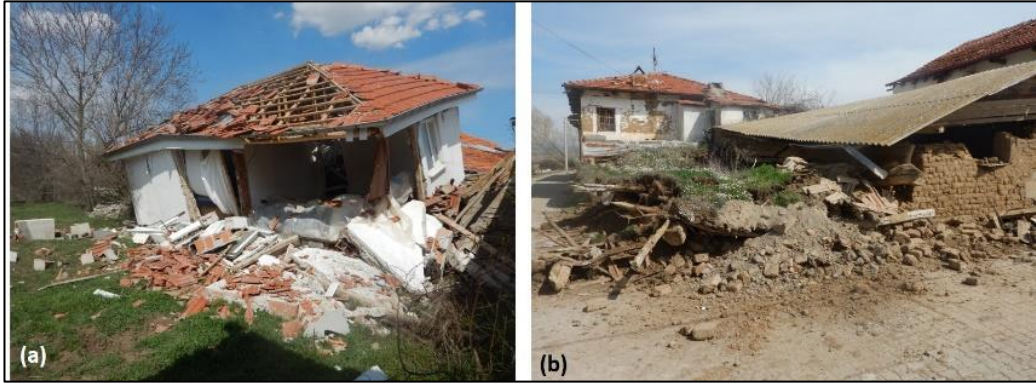
Şekil 7.15: Kırca mahallesinde delikli tuğla ile yapılmış tek katlı binadaki ağır hasar ve tamamen yıkılmış kerpiç yapı.
