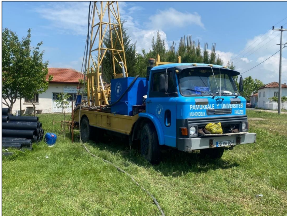
Şekil 2.1: Arazideki sondaj çalışmalarından görünüm
