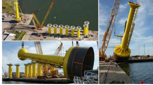
Şekil 1.12. Horns Rev D.Ü.R. Çiftliğinde Kullanılan Vakumlu Kova Keson Temeller (Kutlu, 2011)
