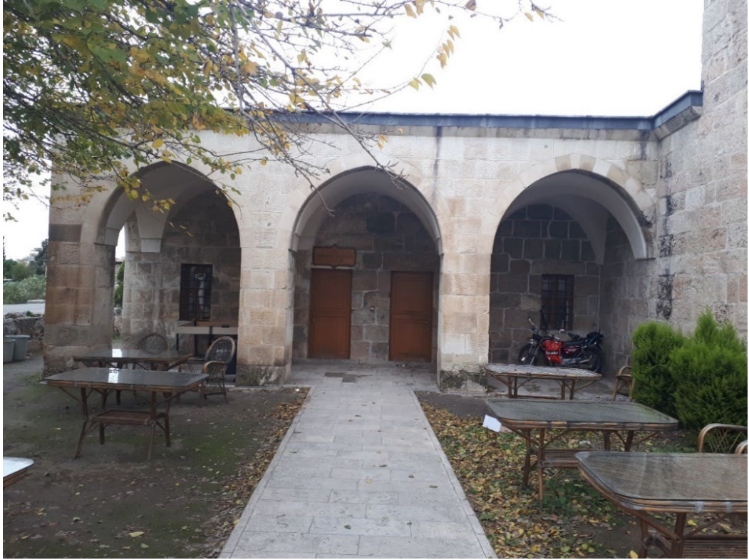
Fotoğraf 50 Sıbyan Mektebi Güneyden Görünüm
