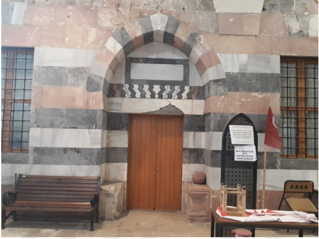
Fotoğraf 48 Hamam Giriş Kapısı ve Pencereleri
