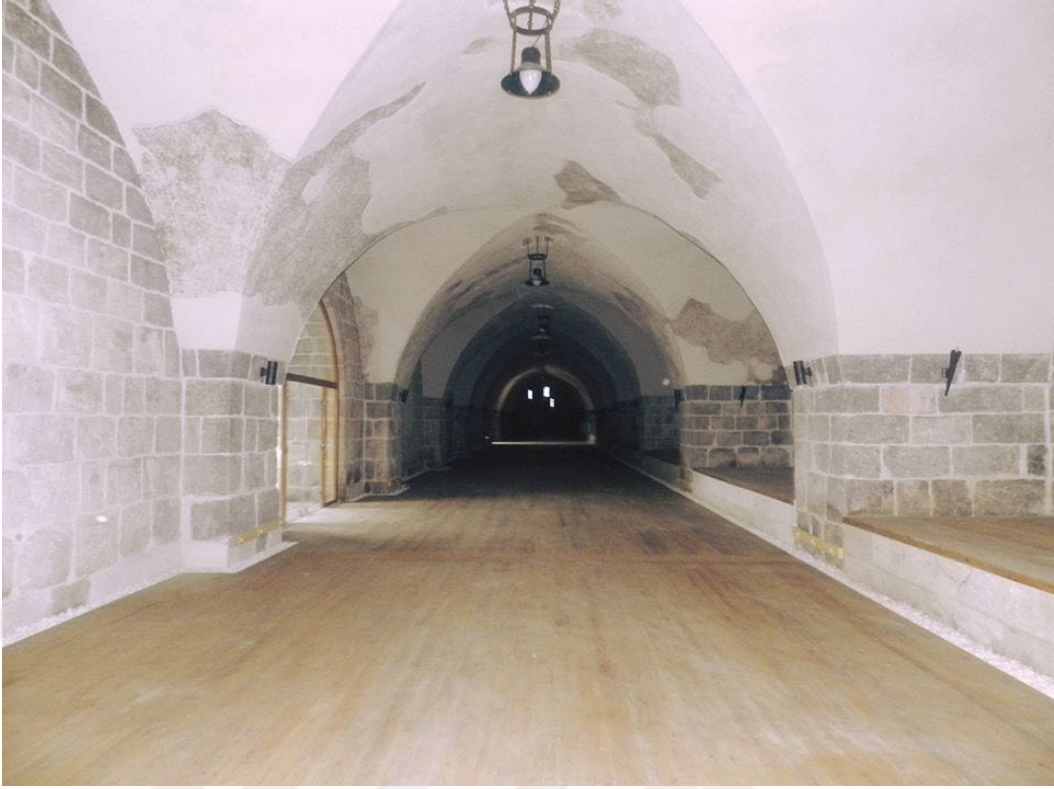
Fotoğraf 20 Kervansaray Güney Kanadı İçi
