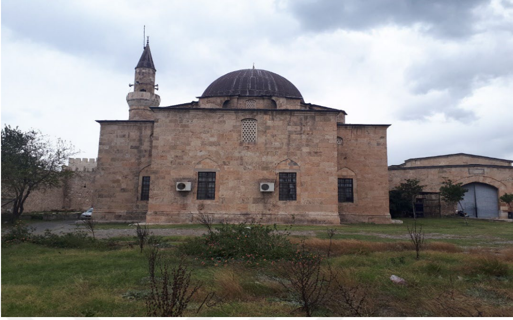
Fotoğraf 38 Cami Güney Cephe
