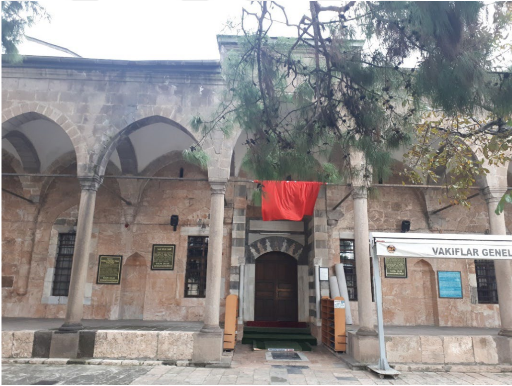
Fotoğraf 35 Cami Kuzey Cephesi
