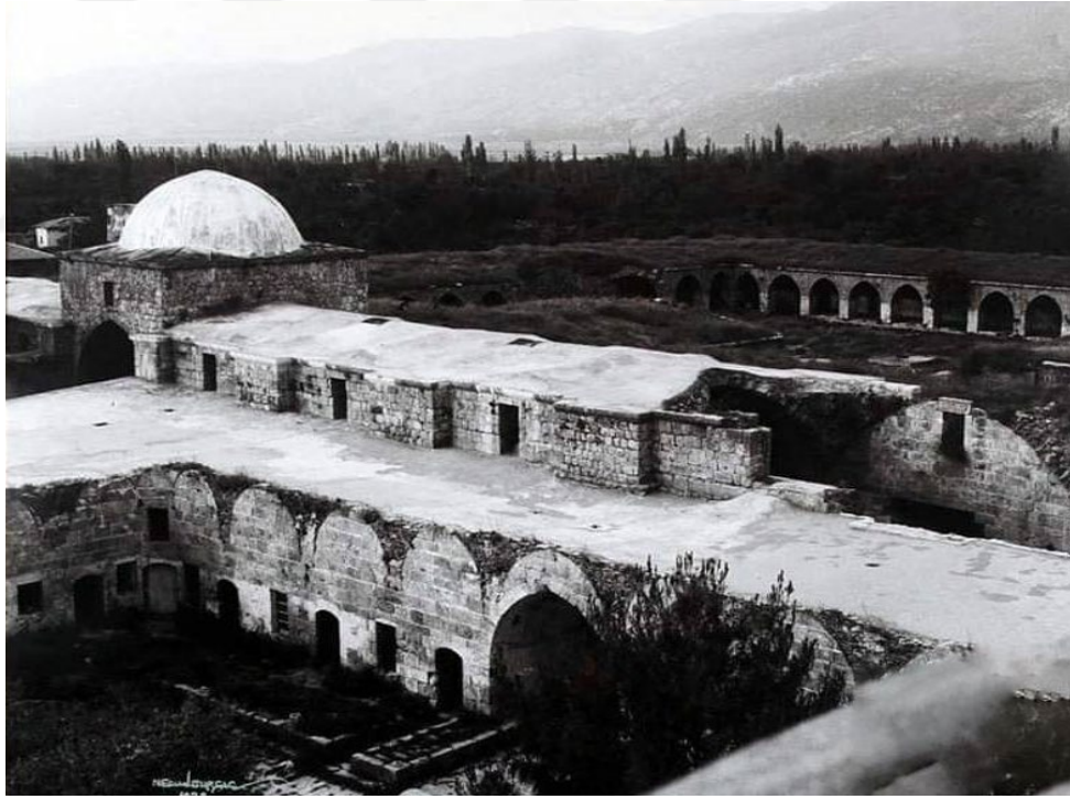
Fotoğraf 10 1967 Yılı Arastanın Güneydoğu Kısım Onarımları (V.G.M.A)
