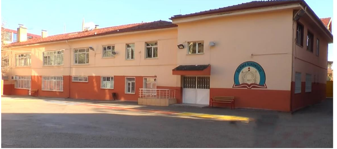
Şekil 4.21. Derme İlkokulu Yeni Binası Arka Cephesi
