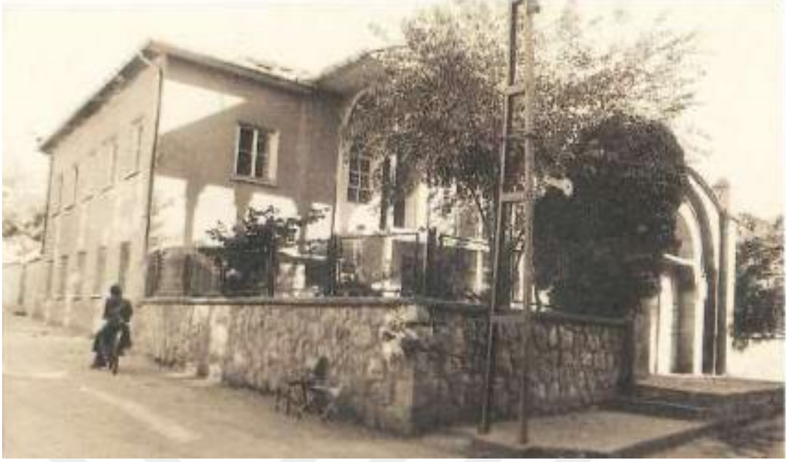
Şekil 4.19. Derme İlkokulu Haziran 1976'da Yıkılmadan Önceki Durumu (Gögebakan, 2004)
