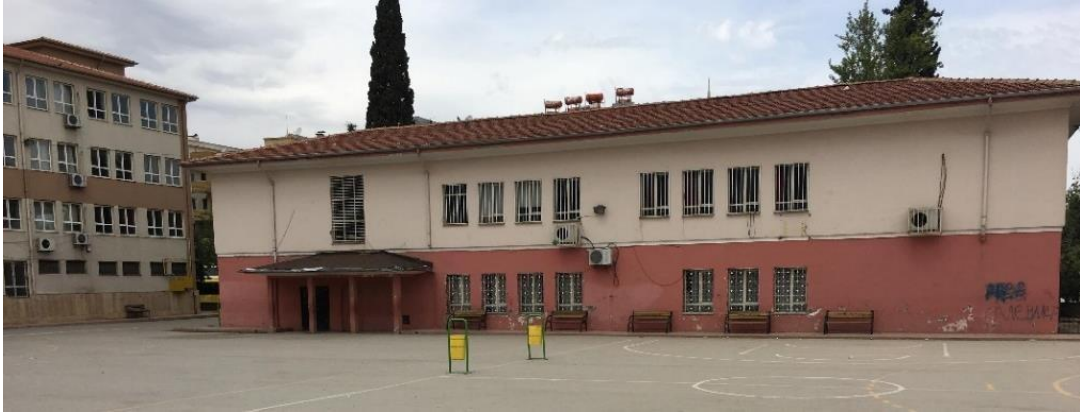
Şekil 4.52. Akyol İlkokulu Yapısı – 2017
