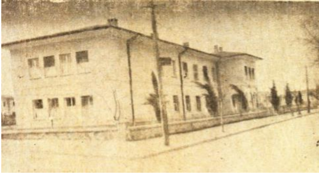
Şekil 4.51. Akyol İlkokulu Yapısı – 1962
