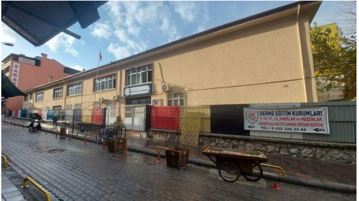
Şekil 4.20. Derme İlkokulu Yeni Binası Giriş Cephesi
