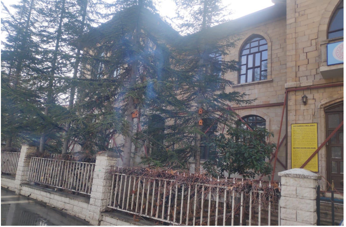
Şekil 4.17. Taş Mektep – Gazi İlkokulu Deprem Sonrası Görünüm (3)
