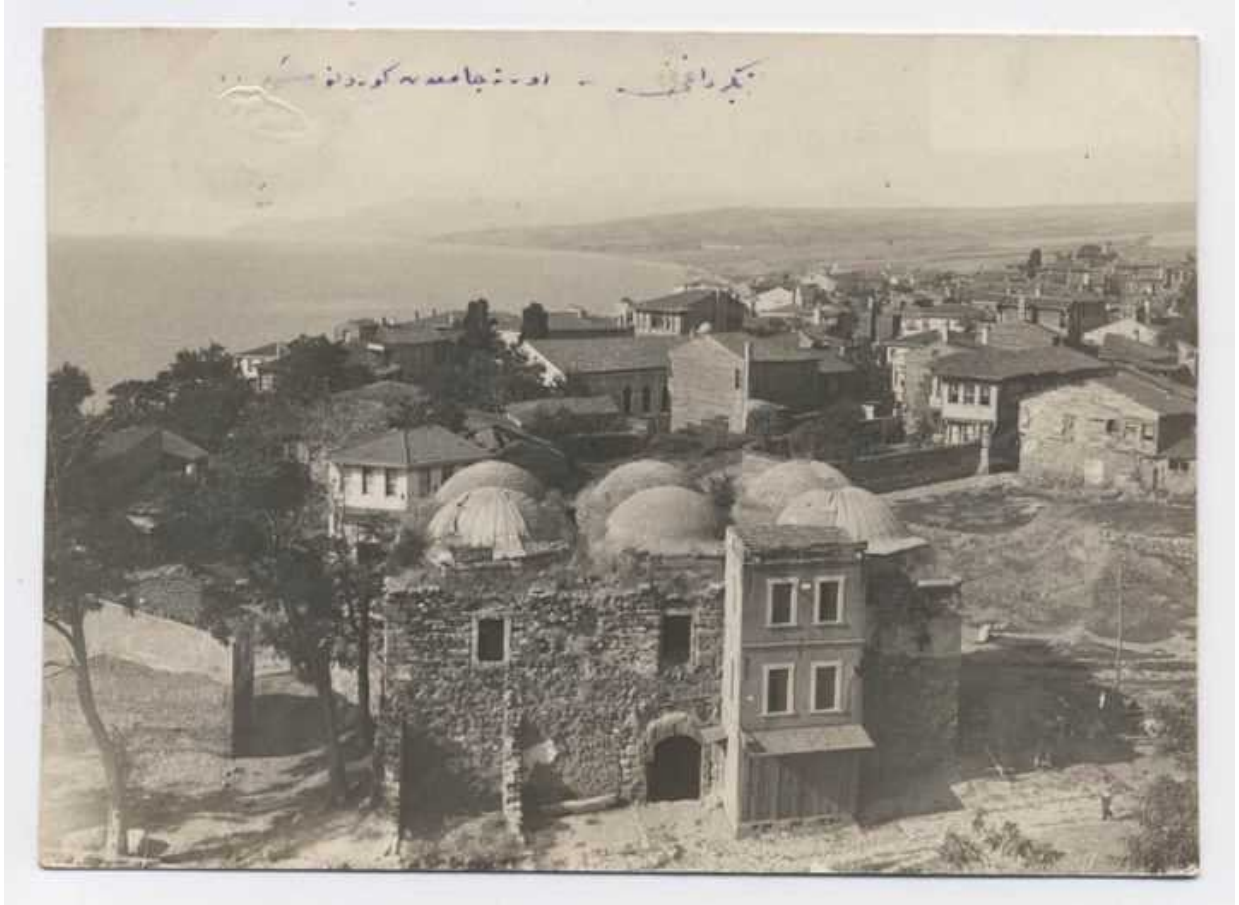
Şekil 3.5. Rüstem Paşa Bedesteni geçmişine ilişkin görünümü (Tekirdağ İl Kültür ve Turizm Müdürlüğü, 2020)
