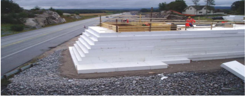
Şekil 9. Geof foam ile Köprü Ayağı İmalatı
