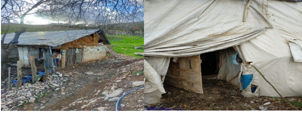
Şekil 3.1. Çalışma kapsamında değerlendirilen işletmelere ait bazı görüntüler
