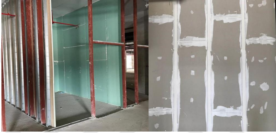
Şekil 1.4 Alçı levha ile çevrilmiş bir oda
