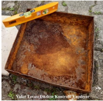
Şekil 6.6. Tavanın Oturacağı Zemin Su Düzeci İle Ayarlanıyor
