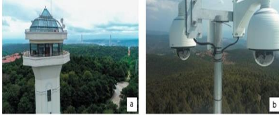
Şekil 1.4. Yangın Gözetleme Kuleleri ve Kameraları
