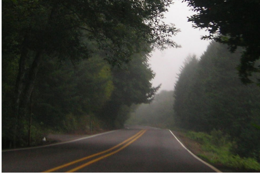
Şekil 1.11 : Asfalt kaplama yol görüntüsü.
