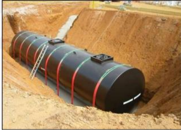
Şekil 3.4. Yer altı depolama tankı (Indiamart, 2024a)
