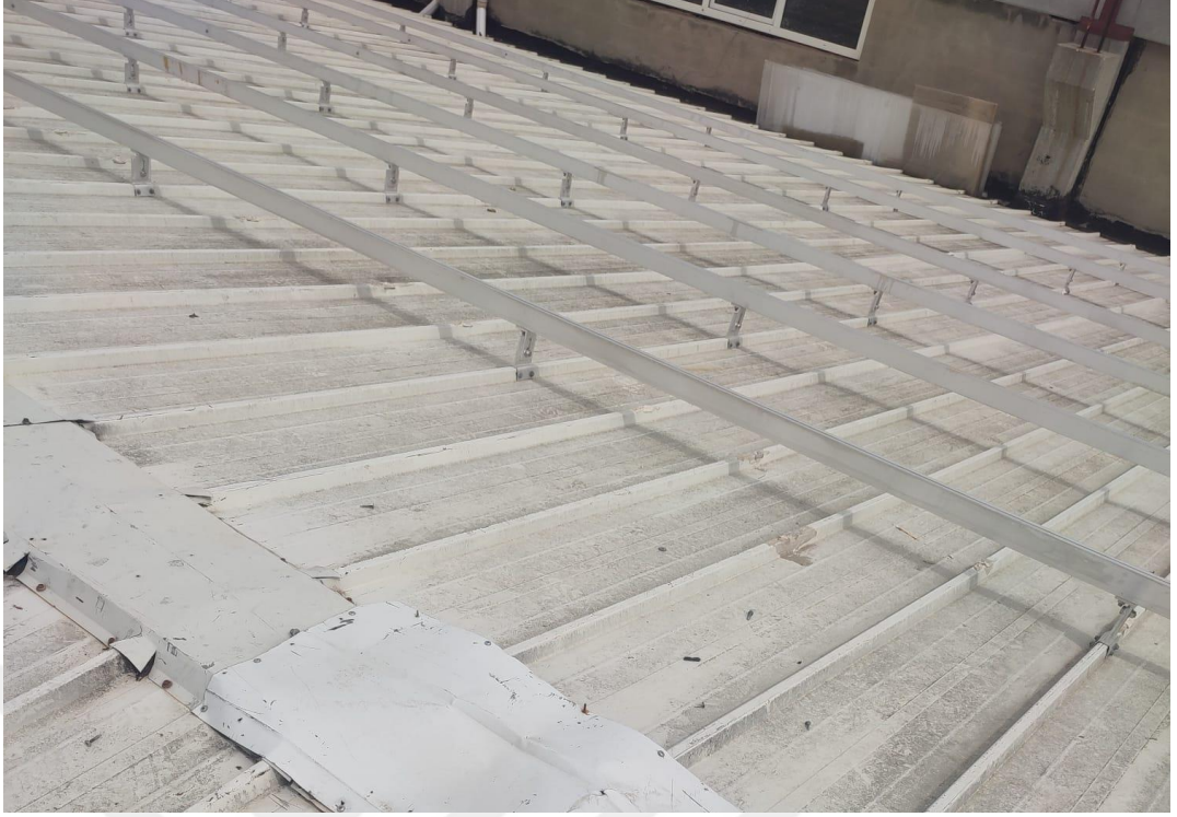
Şekil 5.2 Panel kurulumu öncesi iskelet sistemi (Gaziantep, 2024)
