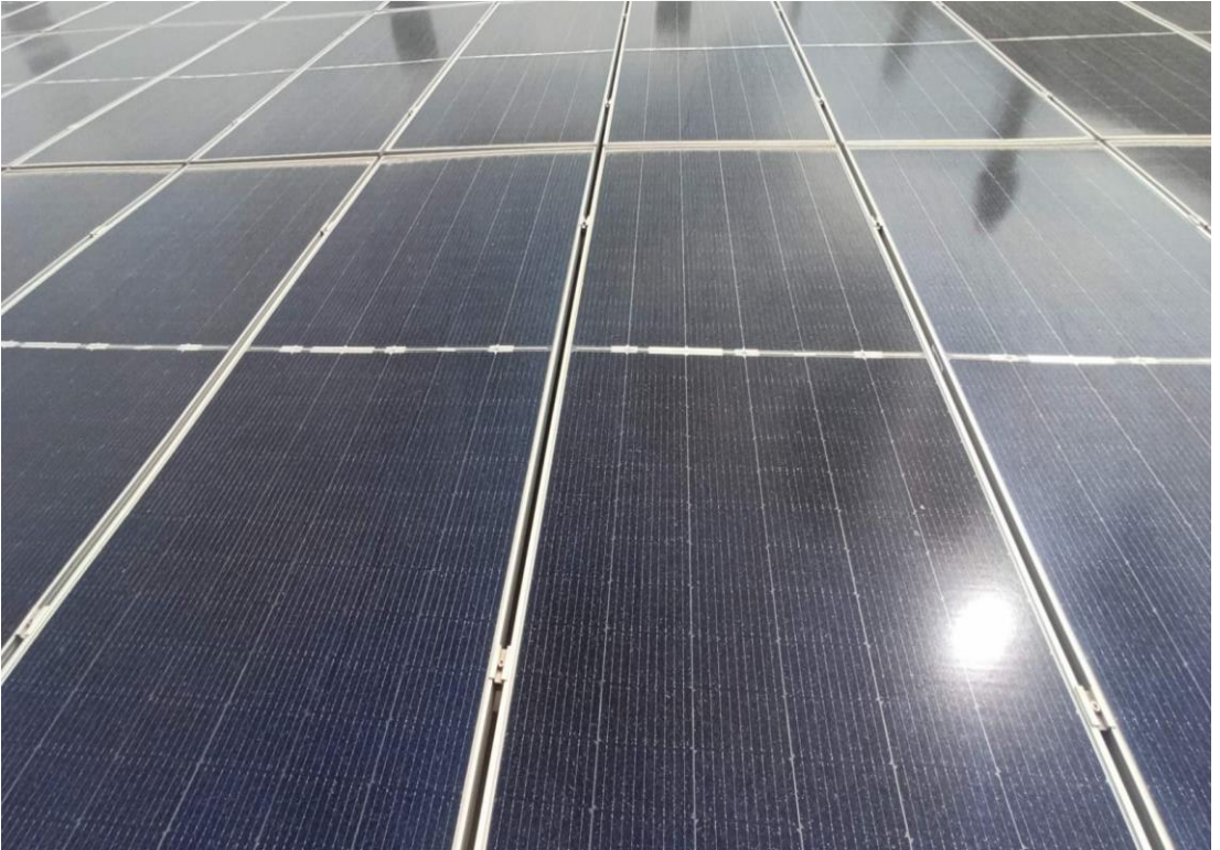
Şekil 5.8 Yıkama sonrası panel (Gaziantep, 2024)
