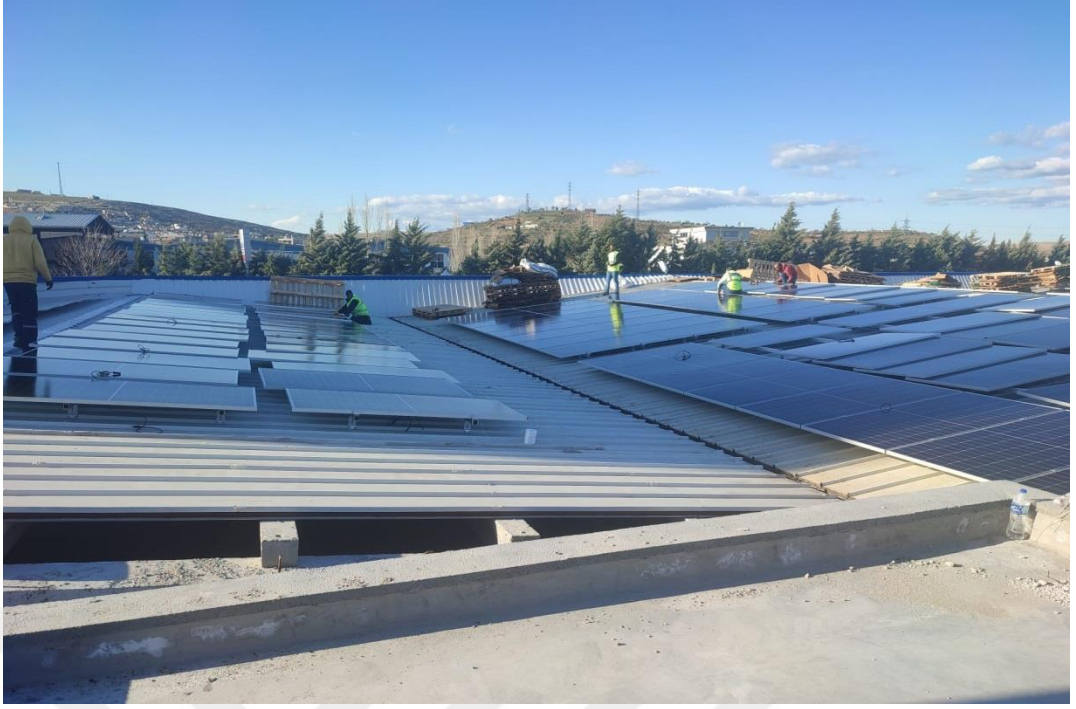
Şekil 5.4 Panel kurulumu (Gaziantep, 2024)
