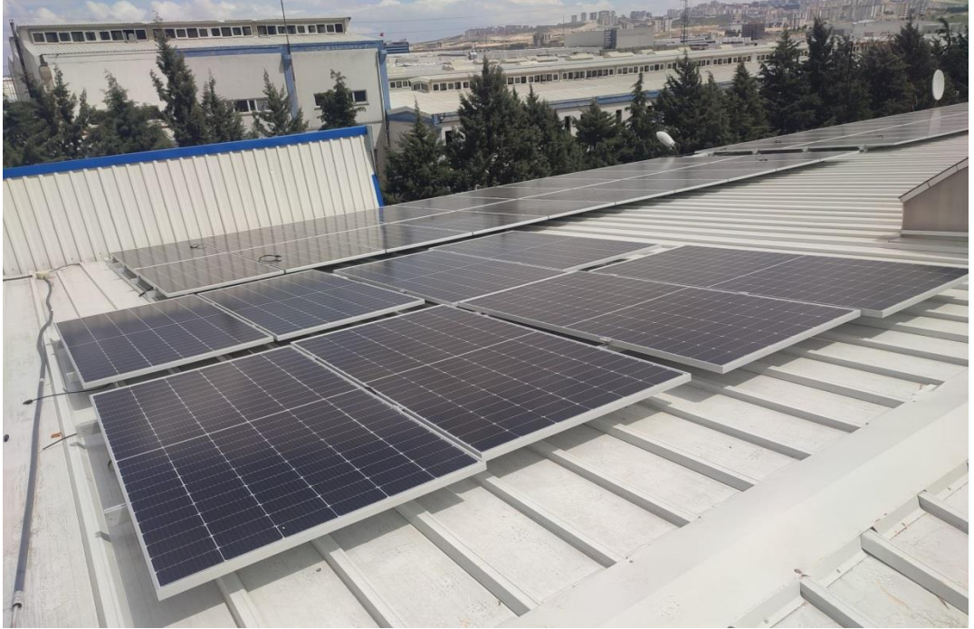
Şekil 5.5 Panel kurulumu (Gaziantep, 2024)
