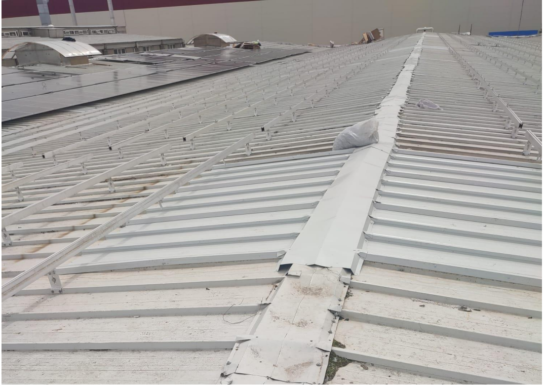
Şekil 5.1 Panel kurulumu öncesi iskelet sistemi (Gaziantep, 2024)
