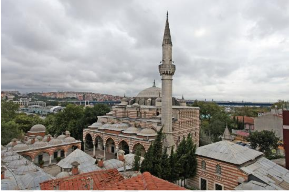
Resim 5. 20. Zal Mahmud Paşa Külliyesi (Url-39)
