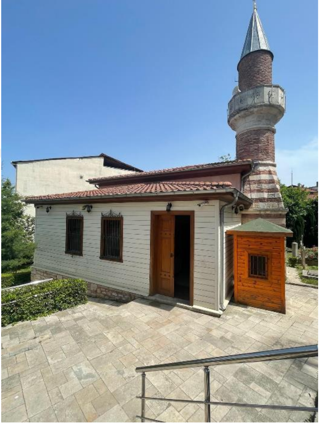
Resim 5. 43. Babüssaade Ağı Davut Ağa Camii Restorasyon Sonrası Görünümü (Fotoğraf: Ayşe Nur Atmaca / Çekim Tarihi: 22.05.2024)
