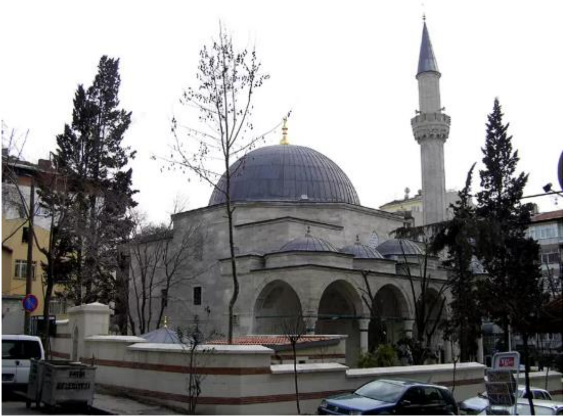
Resim 5. 93. Bâli Paşa Camii (Url-56)
