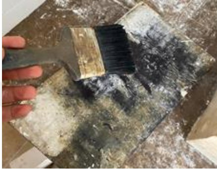
(Kalıp tahtalarına ayırıcı sürülmesi)
