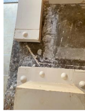
(Teksir kalıp yapım aşaması)
