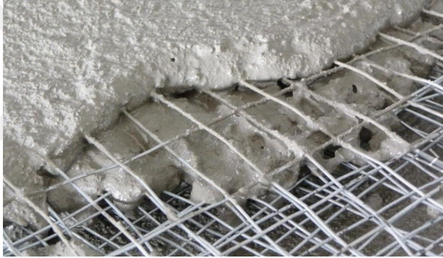
Şekil 8. Ferrocement Uygulamasından Fotoğraf
