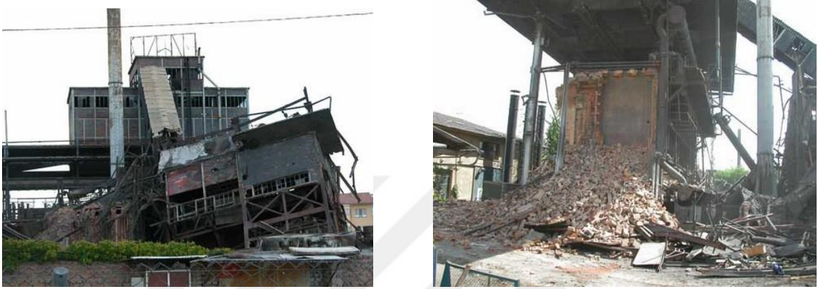
Şekil 3.13. Maltepe Havagazı Fabrikası yıkımından görüntüler (url 3)
