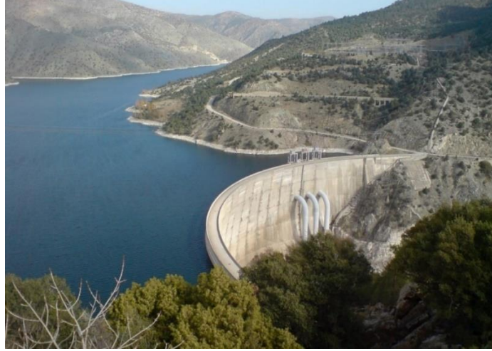
Şekil 4.5. Gökçekaya Barajı (URL-4)
