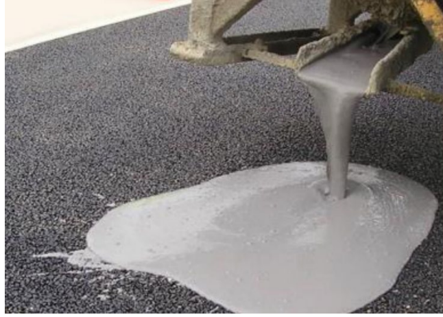
Şekil 2.3. TiO 2 karışımı çimento harcının asfalta dökülmesi işlemi (Crispino, 2010)
