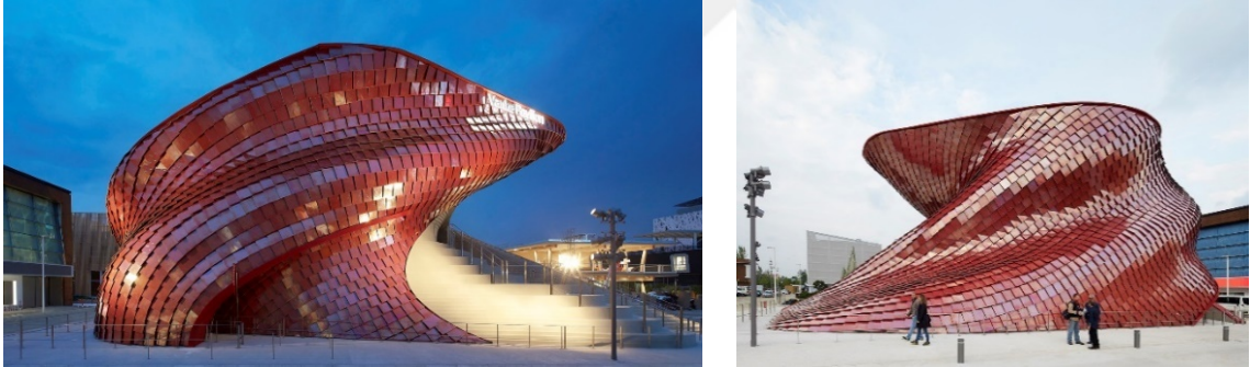
Şekil 2.6, 2.7. Vanke Pavilyonu'nun cephesinde bulunan fotokatalitik seramikler (ArchDaily, 2015)
