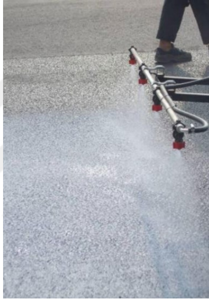
Şekil 2.4. TiO 2 sıvı süspansiyonun püskürtmeli uygulanması (Crispino, 2010)
