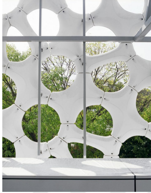
Şekil 2.15. Prosolve370e Modüllerinin çelik taşıyıcıyla olan bağlantısı (Iaac Blog, 2020)
