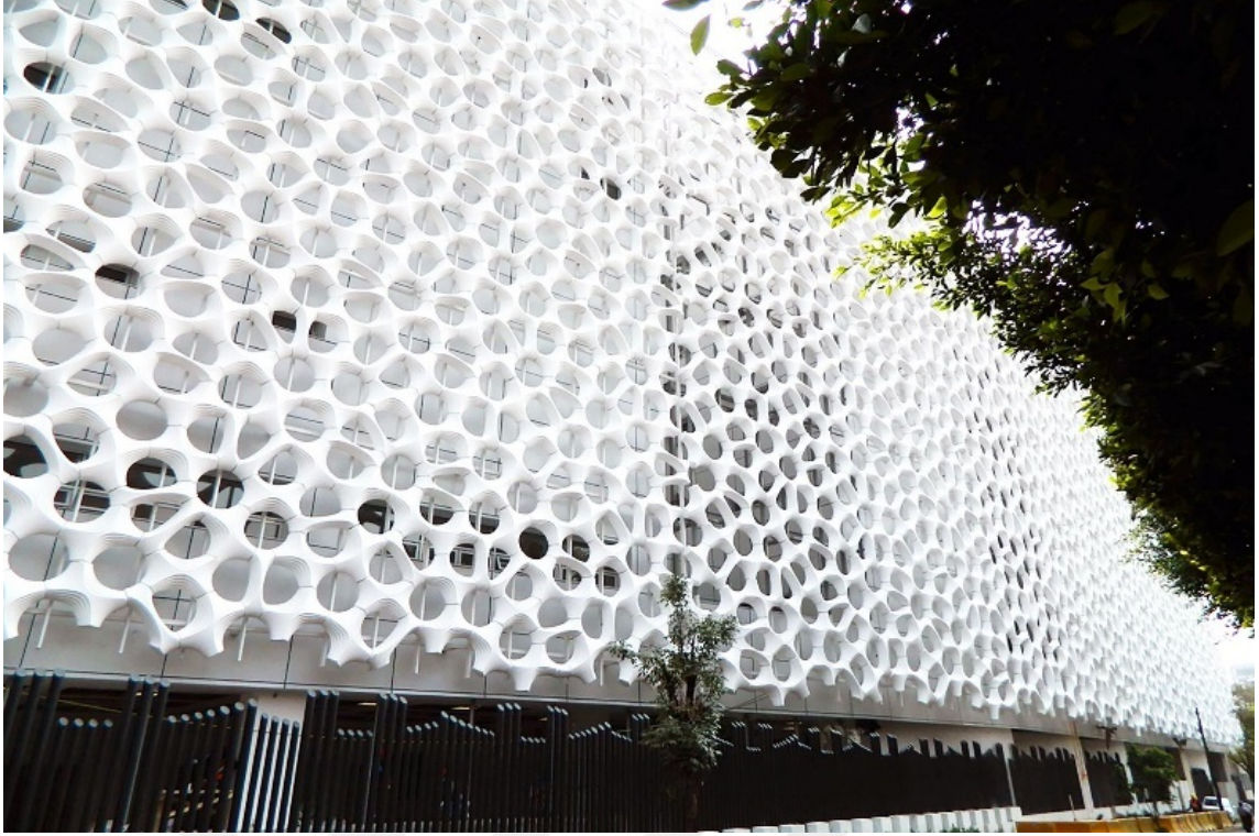
Şekil 2.12. Hastanenin cephesinde bulunan Prosolve370e Modülleri (Zva Architects)
