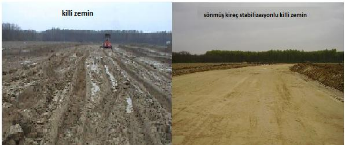
Şekil 1. 3 Killi zeminlerde uygulanan sönmüş kireç stabilizasyonu [13]
