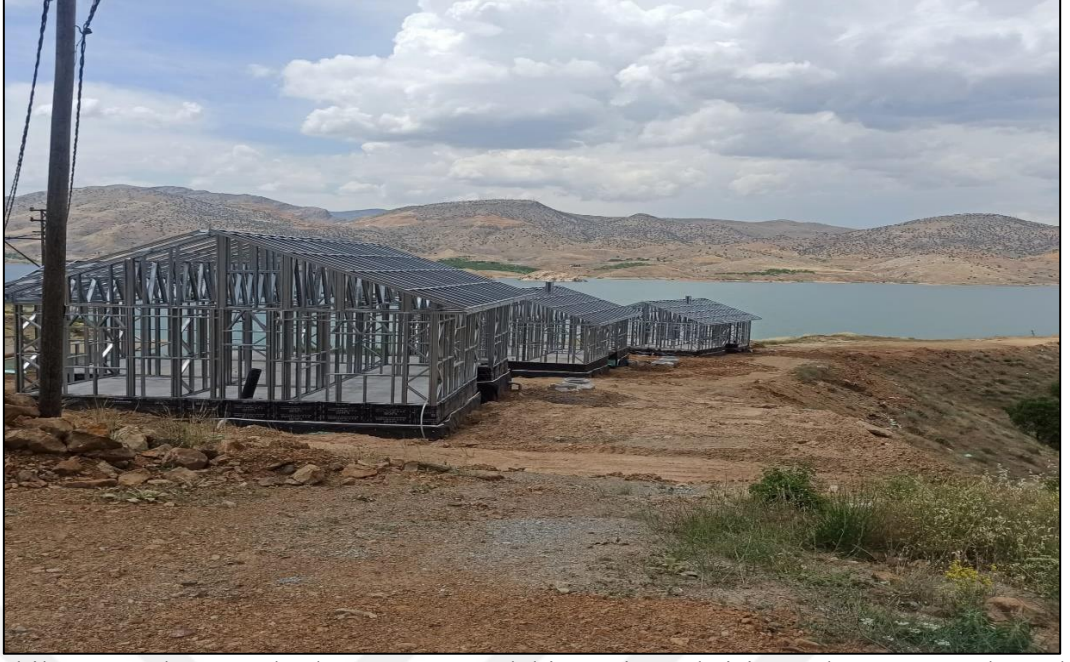
Şekil 4.5. Malatya Kale’de AFAD’ın talebi üzerine tahsisi yapılan orman alanında inşası devam eden çelik kontrüksiyon afet evleri
